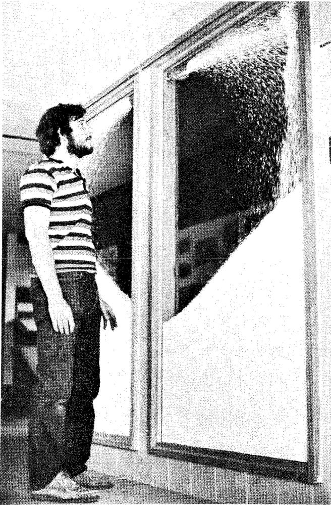
Fenster mit wärmedämmender Streuseifüllung ("Bead Wall"). Der Zwischenraum zwischen den Glasscheiben wird nachts mit Kügelchen aus Polystyrol mithilfe eines Gebläses gefüllt und morgens wieder entleert - eine Entwicklung von Steve Baer (Quelle 15).
