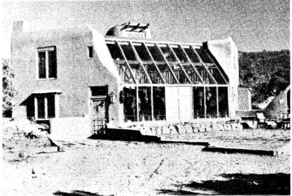
Dieses Haus vereinigt in einfacher Form verschiedene Prinzipien der passiven Sonnenenergienutzung, wie günstige Glasflächenorientierung, kompakte Bauweise, Wärmezonung, Nutzung von Wärmeüberschüssen (Die Sonne liefert bei diesem Haus an einem strahlungsreichen Standort im Süden der USA 80% der benötigten Raumwärme).
