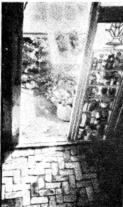
Je größer die direkt oder diffus bestrahlte Oberfläche der Speichermasse ist (richtige Orientierung, geringe Verschattung), je besser das Absorptionsvermögen der Oberfläche (dunkle Färbung, matt statt glänzend), je höher die Wärmeleitfähigkeit und je größer das Wärmespeichervermögen des Speichermaterials ist, desto mehr Sonnenenergie kann eingespeichert werden. Bei einseitiger Bestrahlung beträgt die nutzbare Dicke massiver Primär-Speicherwände 20 - 25 cm (Quelle 78).
