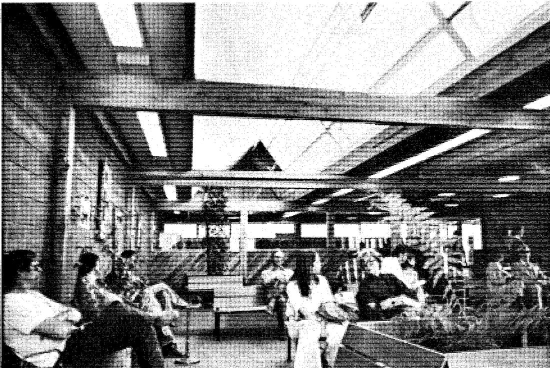
Schrägstehende Dachoberlichte sorgen für guten Einfall direkter und diffuser Strahlung. Die Shed-Unterseiten tragen mit ihren hellen Oberflächen (innenliegende Reflektoren) zur Verteilung der Licht- und Wärmestrahlung bei (Quelle 15).
