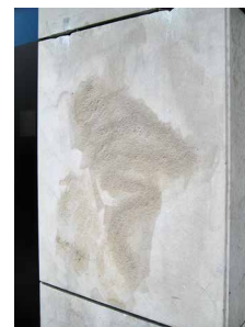
Graffiti an einer Hauswand (links). Bei unsachgemäßer Entfernung bleiben Spuren (rechts). [© Urs Müller]
