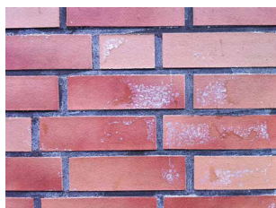
Feuchteschäden an dampfdichten Anti-Graffiti-Beschichtungen auf Ziegel- (links) und Natursteinmauerwerk (rechts) [© Urs Müller]
