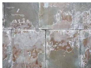
Feuchteschäden an dampfdichten Anti-Graffiti-Beschichtungen auf Ziegel- (links) und Natursteinmauerwerk (rechts) [© Urs Müller]
