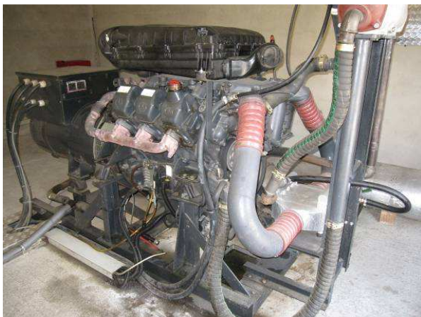
Abbildung 36: BHKW-Modul (links) und Trocknungsanlage (rechts) Anlage 18
