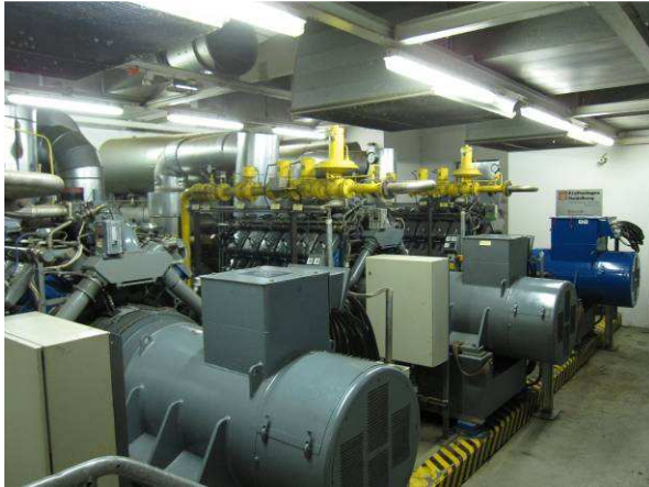
Abbildung 30: BHKW-Module (links) und Spitzenlastkessel (rechts) Anlage 12
