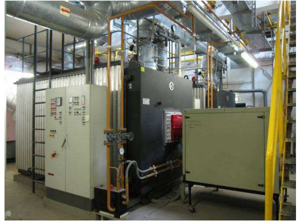
Abbildung 30: BHKW-Module (links) und Spitzenlastkessel (rechts) Anlage 12
