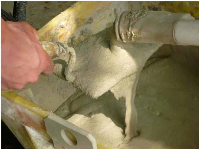
Abbildung 67: Pumpbare KLM Leichtbetonmischung
