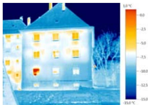
in vorliegendem Fall mit einer durchgehenden wasserführenden Fassade. Neben dem Wärmeverlust durch die Fensterstürze sind auch die Heizkörpernischen als weitere Inhomogenitäten der Fassade erkennbar, die zu unterschiedlichen Oberflächentemperaturen führen (siehe).
