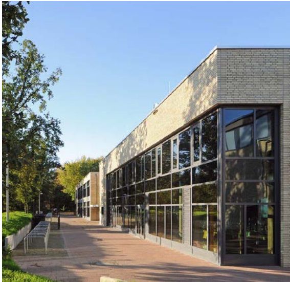
Abb. 7 Ostfassade mit der Aula im Vordergrund
