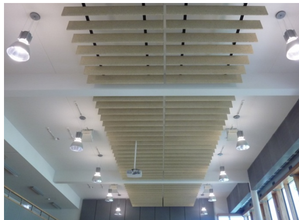
Abb. 16 Thermisch nutzbare Massivdecke
