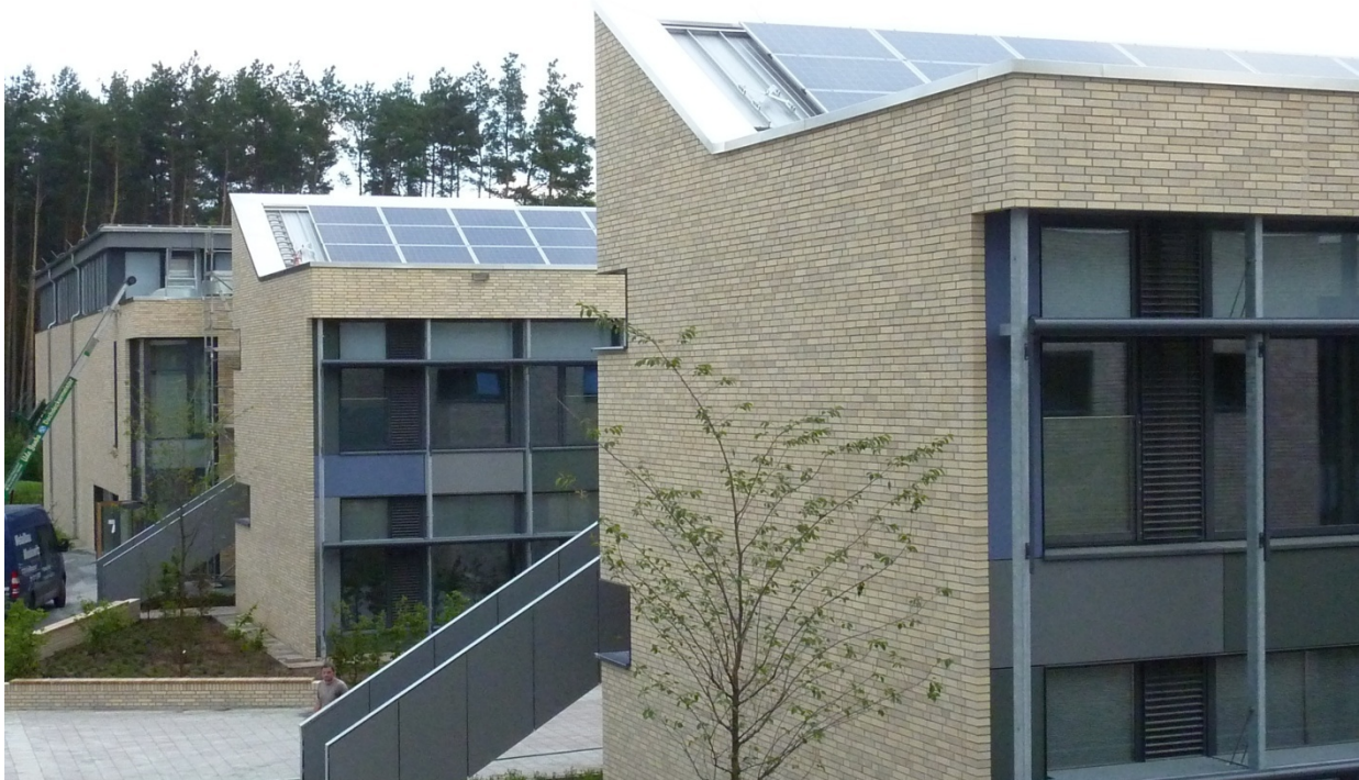
Abb. 29 Integration der Solaranlage in die Dachflächen
