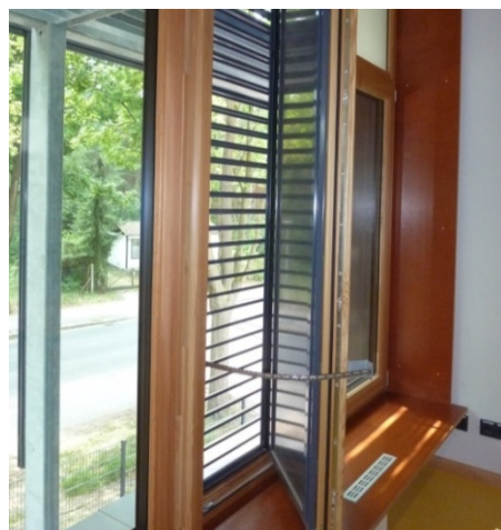
Abb. 17 Automatische Lüftungsklappe
