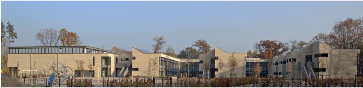
Abb. 2 Gesamtansicht der Schule und Sporthalle von Westen
