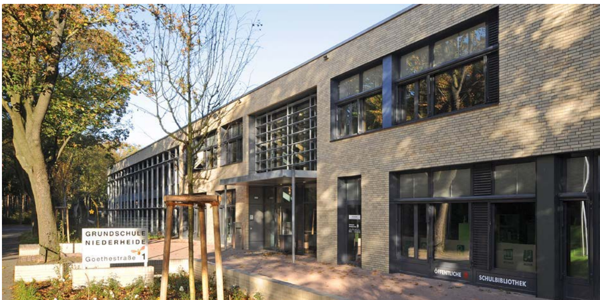
Abb. 4 Blick auf den Haupteingang an der Goethestraße
