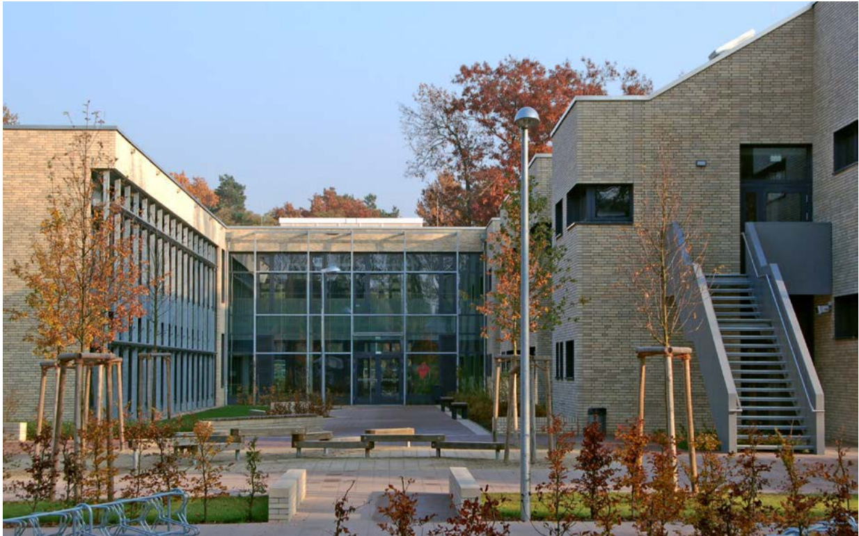
Abb. 5 Blick in einen Hof zwischen den Klassenflügeln
