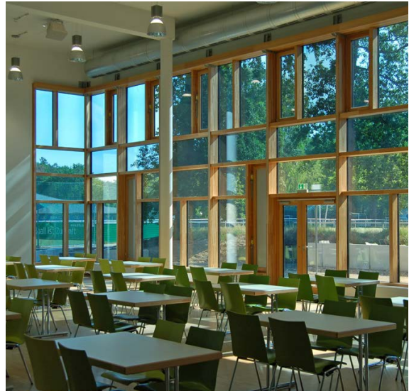
Abb. 9 Aula mit elektrochromer Verglasung (E-Control)
