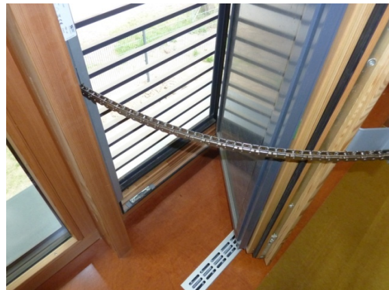
Abb. 26 Automatischer Lüftungsflügel
