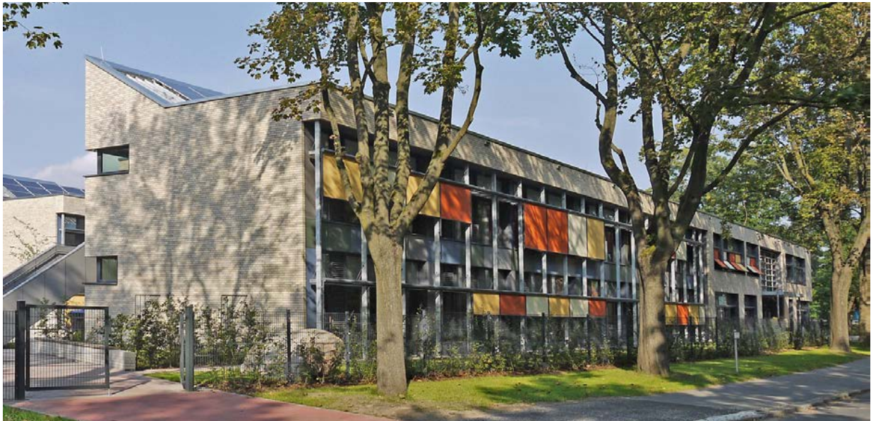
Abb. 3 Südansicht von der Goethestraße
