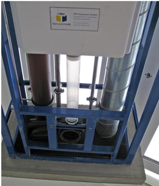
Bild 18: Installationsmodul mit integriertem Brandschott (IFF Weimar e. V. 2013), Foto Rebel
