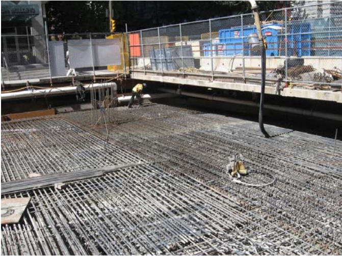
Figure 11. Horizontal joint pour in slab
