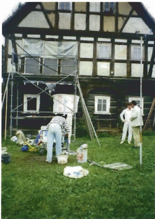
Abb. 1: Einbau des neuen Ausfachungsmaterials in drei Gefache der Testwand im Umgebindehaus Ebersbach / Oberlausitz
