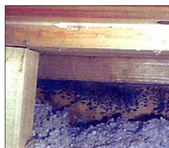
Bild 2 Tauwasserausfall und Schimmelpilzbefall an der oberen kalten Gefachecke in hochgedämmten Holz-Außenwandgefachen
