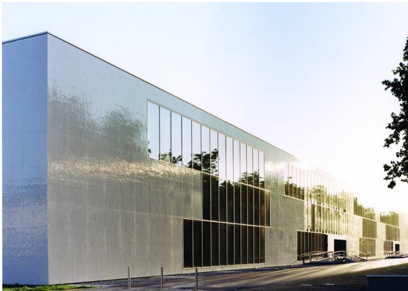
Abbildung 1 VH-Fassade mit irisierenden Glas-Kompositelementen (rückseitig befestigt) am Dienstleistungs- und Service-Center der GEWOGE, LUWOGES BASF GmbH in Ludwigshafen. Architekten: Allmann Sattler Wappner
