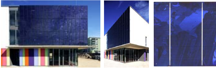
Abb. 4 Südfassade Kinderkrippe und Jugendfreizeitstätte in München, Quelle: www.baunetz.de
