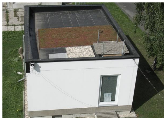
Abbildung 1 Versuchsgebäude in Leipzig
