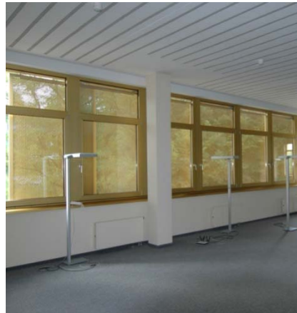
Bild 7: Installierte Absorberstreifen aus porositern Glas in thermisch aktiver Betondecke in einem Mehrpersonenbüro [5] und gemessene Nachhallzeiten mit und ohne Absorberstreifen.
