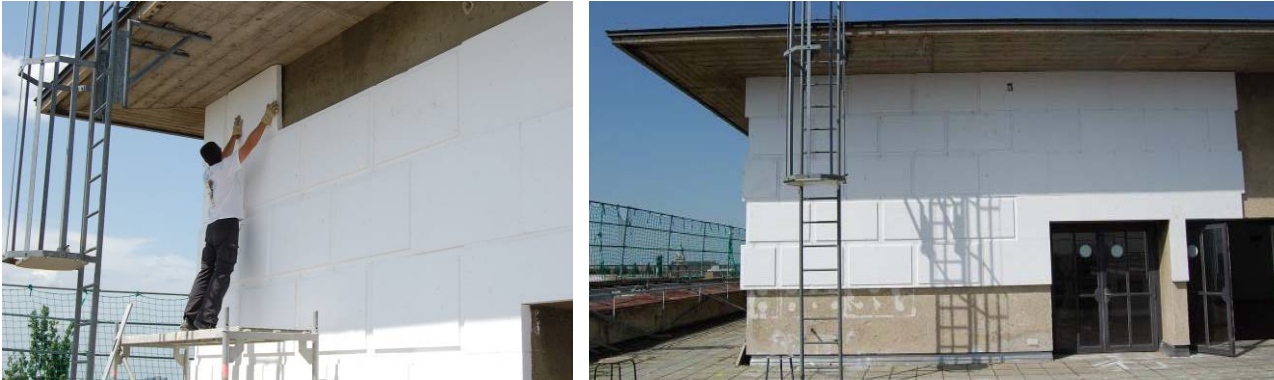
Abbildung 6: Musterfassade während und unmittelbar nach der Montage
