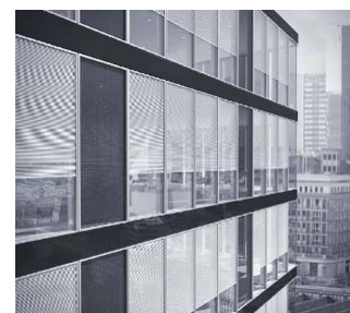
Abb. 1 Ansicht E 2 -Fassade
