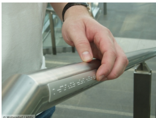
Abbildung 3: Taktile erfassbare Beschriftung (Punktschrift) an einem Handlauf [Quelle: DBSV]
