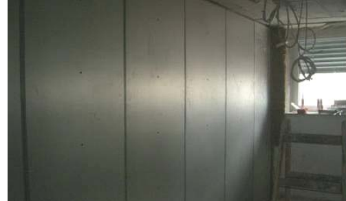
Abb. 7 Wandflächen-Paneele in Position
