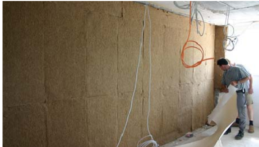
Abb. 6 Hanffaser-Dämmmatten als Ausgleichsschicht
