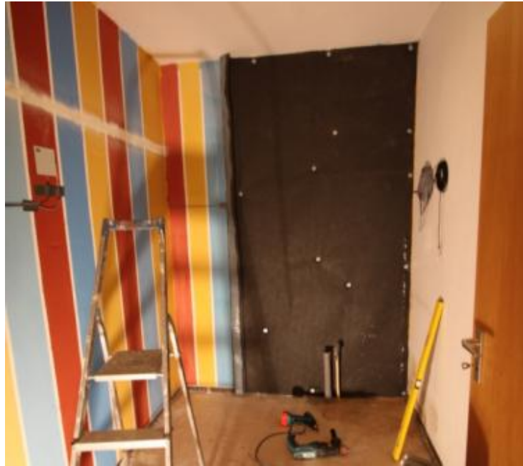
Bild 1: Ansicht_Messraum.jpg Innenansicht im Versuchsgebäude mit den Wänden Ost und Süd mit Farbfeldern und zum Teil verlegter Klebmatte.
