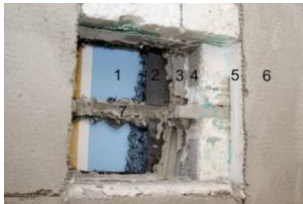
Bild 4: Innendämmaufbau_VIP.jpg Bauteilöffnung der Innendämmung als Befundtreppe auf der Ostwand.
