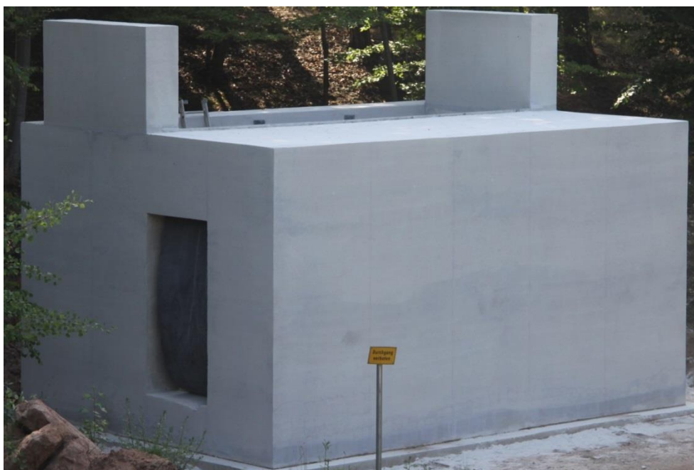
Abbildung 4: Experimentalgebäude aus Architekturleichtbeton nach den Betonarbeiten
