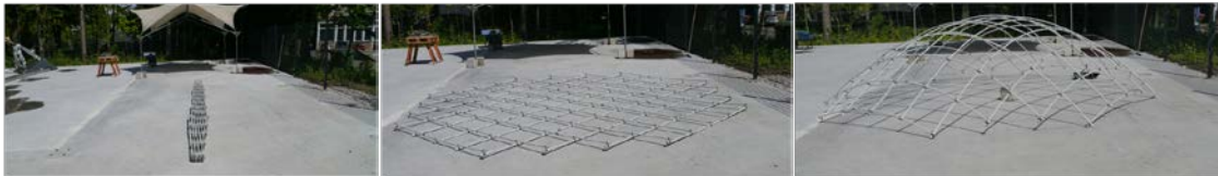
Abbildung 1.6: Sequenz der kinematischen Errichtung durch Auflagerverschiebung des Demonstrators
