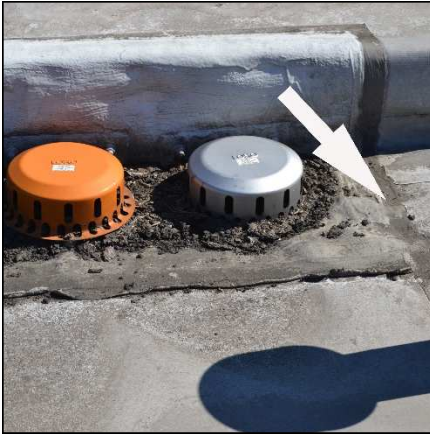
Bild 7-2: Kein Ablösen und Aufkräuseln der FLK im nicht von Wasser überstauten Bereich (Pfeil)
