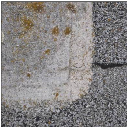
Bild 7-1: Schadensfrei gealterter Übergang
