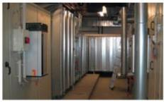
Die Änderung der Betriebsart der Lüftungsanlagen in Alt- und Neubau von Konstant- zu CO<sub>2</sub>-geführtem Luftwechsel führt zu einer erheblichen Einsparung von elektrischer Ventilatorenergie. Thermische Einsparungen ergeben sich ebenfalls, werden in der Bewertung der Wirtschaftlichkeit dieser Maßnahme jedoch nicht berücksichtigt. Komforteinbußen werden nicht spürbar, da ein CO<sub>2</sub>-Grenzwert von 850 ppm berücksichtigt wird.
