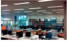
Durch einen Austausch der herkömmlichen Leuchtstoff-Röhren und Einbau von insgesamt 226 LED-Replacement-Röhren, bei denen die vorhandene Leuchte erhalten bleibt, wird die Anschlussleistung von 15,2 auf 5,7 kW reduziert. Gleichzeitig entsteht durch die tageslichtähnliche Lichtfarbe eine wesentliche angenehmere Arbeitsatmosphäre. Die LED-Röhren haben zudem eine ca. 6 mal längere Lebensdauer gegenüber der ursprünglich verbauten Variante.
