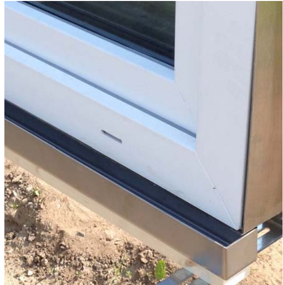
Abbildung 3 Detail in Halteschale montiertes Fenster und Sammelrinne
