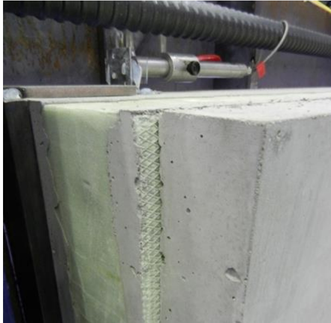
Bild 5: Ablösung der Dämmung vom Beton in der Kontaktfuge
