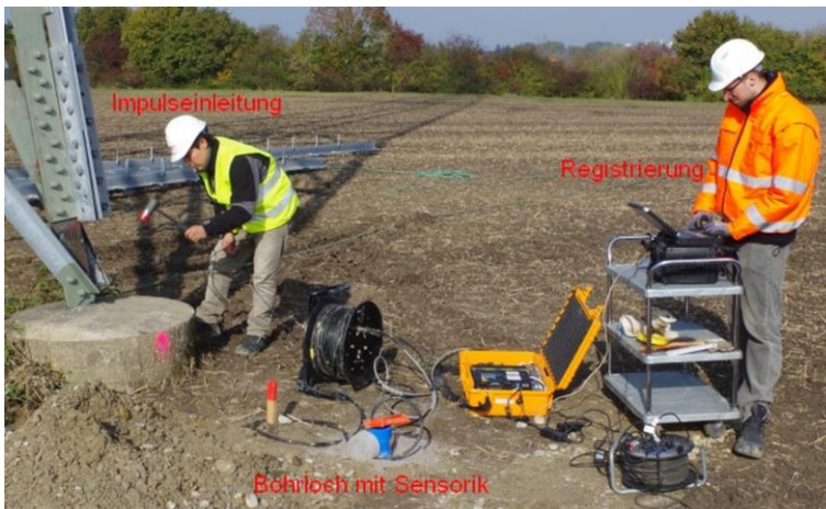
Bild 4: Einsatz des Parallel-Seismik-Verfahrens zur Längenbestimmung an Bestandspfählen
