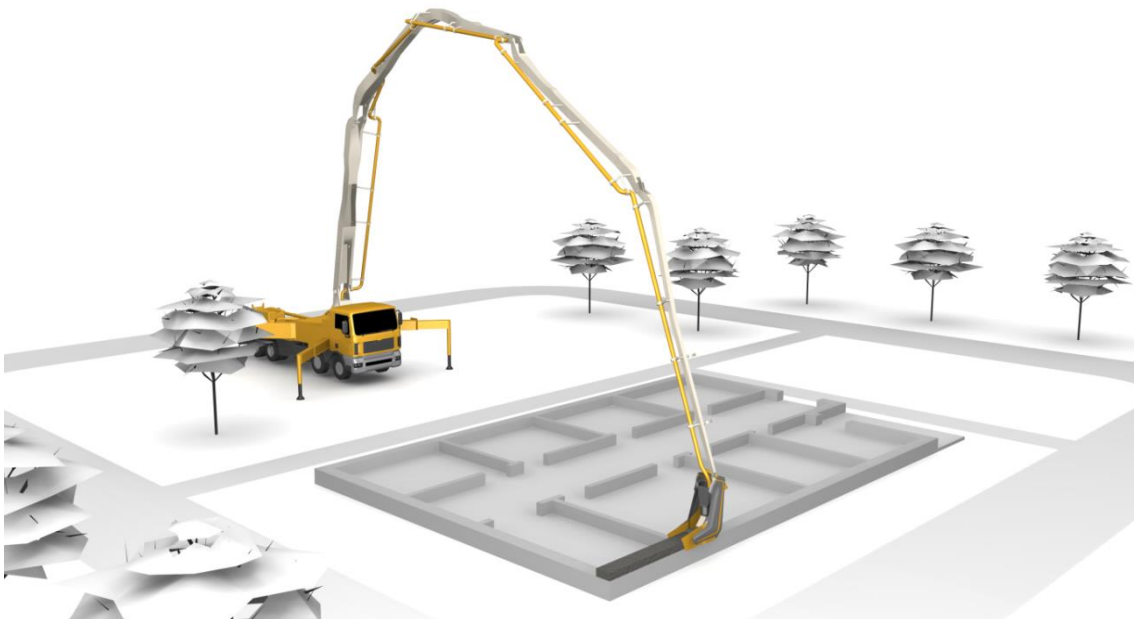
Bild 2: Beton-3D-Druck direkt auf der Baustelle (Animation)
