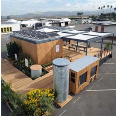
Abb. 1 Außenansicht nexushaus (Blick aus Süd-West)
