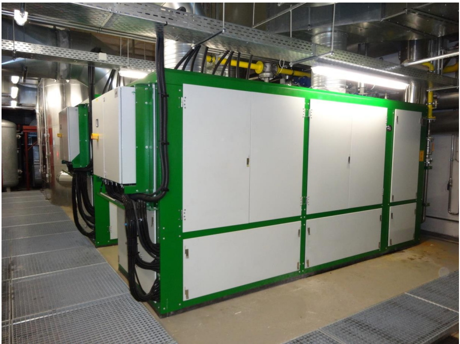
Abbildung 4: BHKW-Module der BHKW-Anlage D
