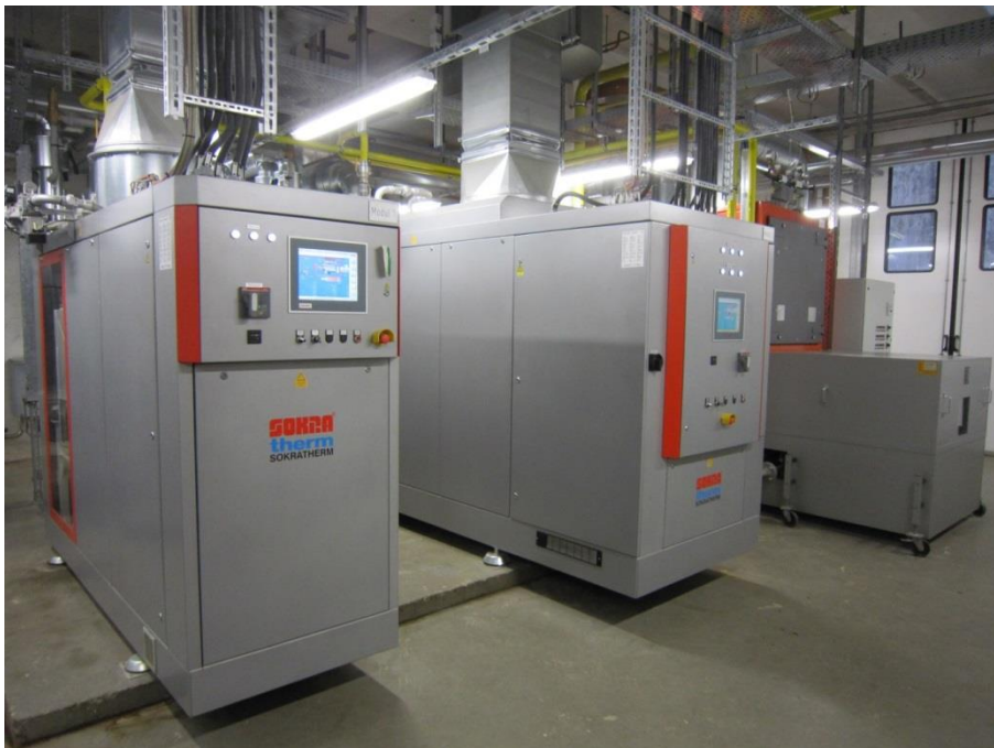
Abbildung 2: BHKW-Module der BHKW-Anlage B
