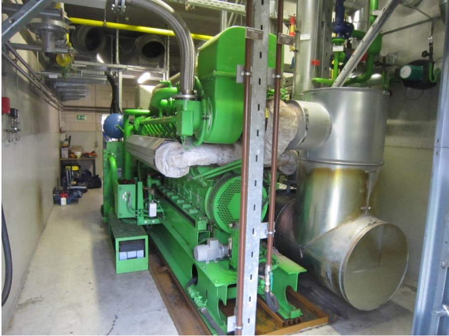
Abbildung 3: BHKW-Modul der BHKW-Anlage C
