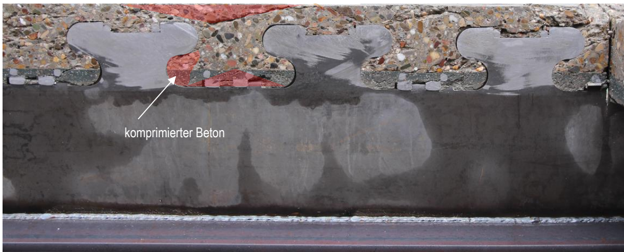
Bild 7: Ausschnitt aus dem Sägeschnitt entlang der Verbundfuge nach dem Versuch beim Versuchsträger „Endzustand“
