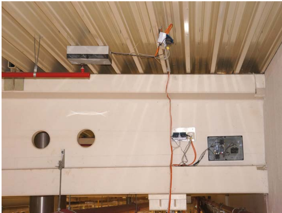
Bild 5: Installiertes Messsystem am Dachtragwerk einer Industriehalle
