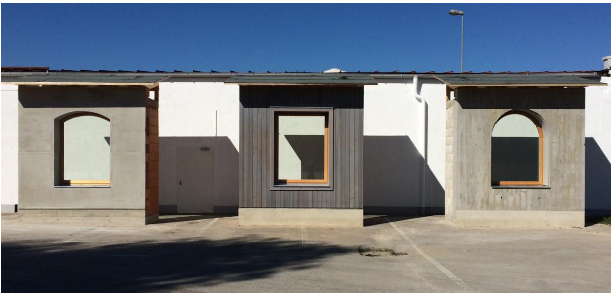
Abbildung 11: Drei Fassadenmodelle in den Bauweisen wärmedämmendes Mauerwerk, Massivholz und Leichtbeton
