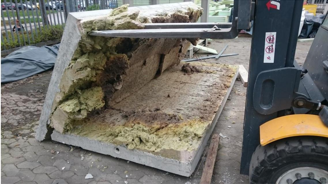
Abbildung 3: Ausbau der Sandwichwand.jpg
