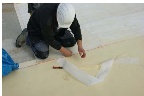
Bild 1: Verlegung einer Frischbetonverbundfolie/-bahn auf einer Sauberkeitsschicht vor dem Bewehren und Betonieren [Quelle: DBV, Kiltz]
