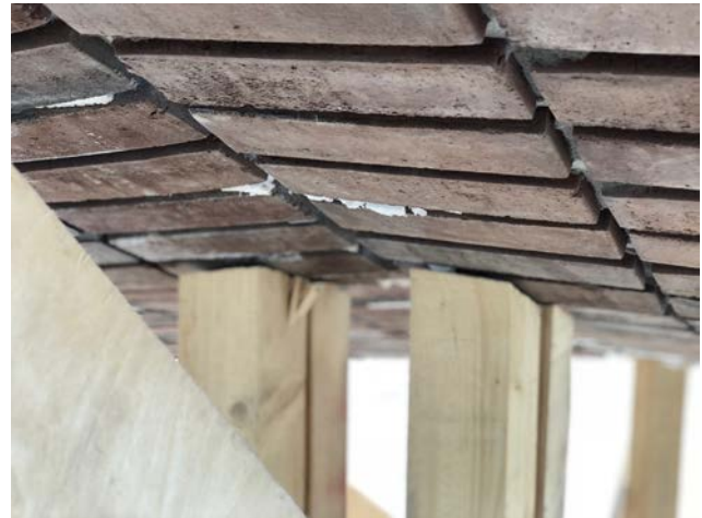
Abbildung 9: Versuchsreihe 2: Lehrgerüst - Auflagerung Fertigteil, A2
