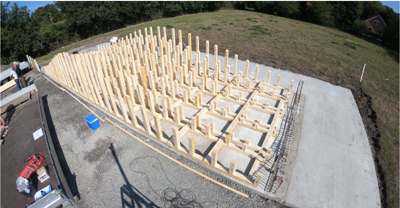
Abbildung 11: Aufgebautes Lehrgerüst ohne Queraussteifung, A2
