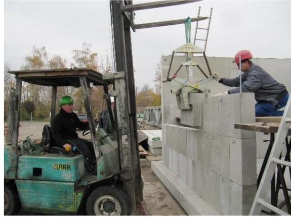
Bild 15 *Demontage eines RC-Betonsteines mit der Winkelementzange*
