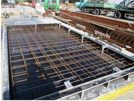
Bild 12 *RC-Deckenplatte 1, Schalung, Verbindungstechnik*
