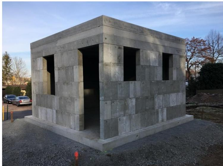
Bild 17 *Vollständig re-montiertes Modul am neuen Standort*
