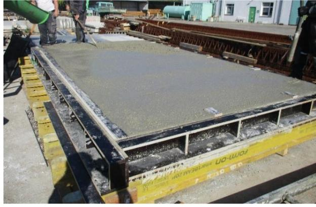
Bild 13 *RC-Deckenplatte 1, Betonlage*
