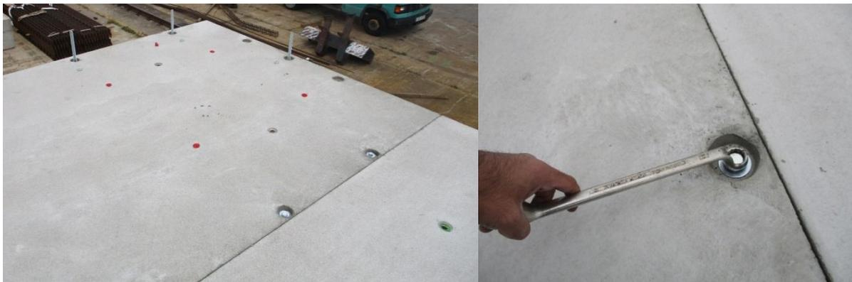
Bild 2 Schraubverbindungen der RC-Deckenplatten
