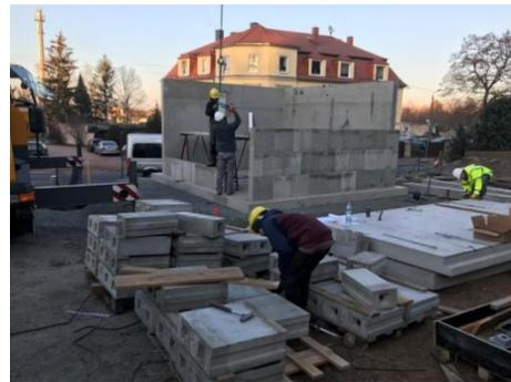
Bild 16 *Re-Montage am neuen Standort – Abdichtung gegen aufsteigende Feuchtigkeit auf der Bodenplatte li. – Wandmontage re.*
