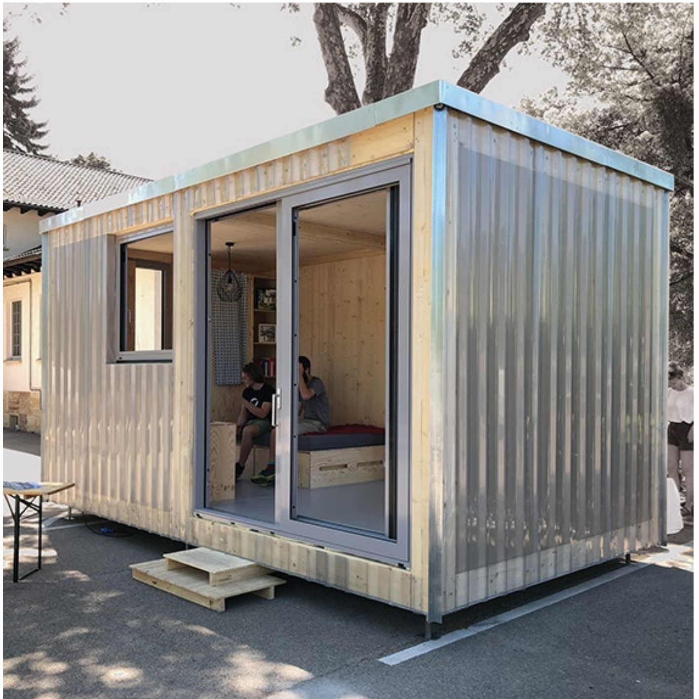
Demonstrationsbau aus zwei Rastermodulen des Bausystems
