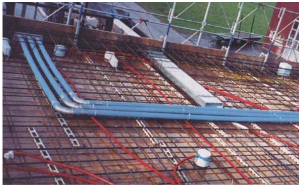
Bild 1: Diverse Leitungsführungen in einer Stahlbetondecke
