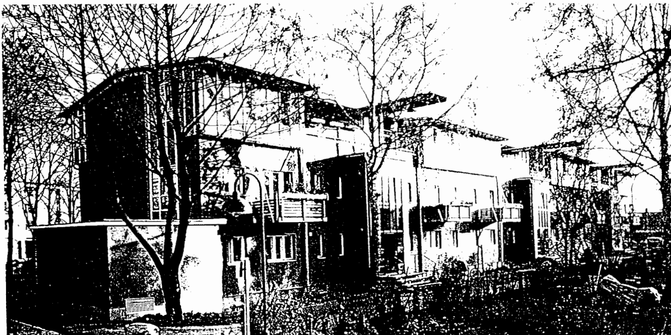
Modernisierung und Aufstockung zweigeschossiger Häuser mit "Einfachwohnungen" (Berlin-Neukölln, Schlierbacher Weg)
