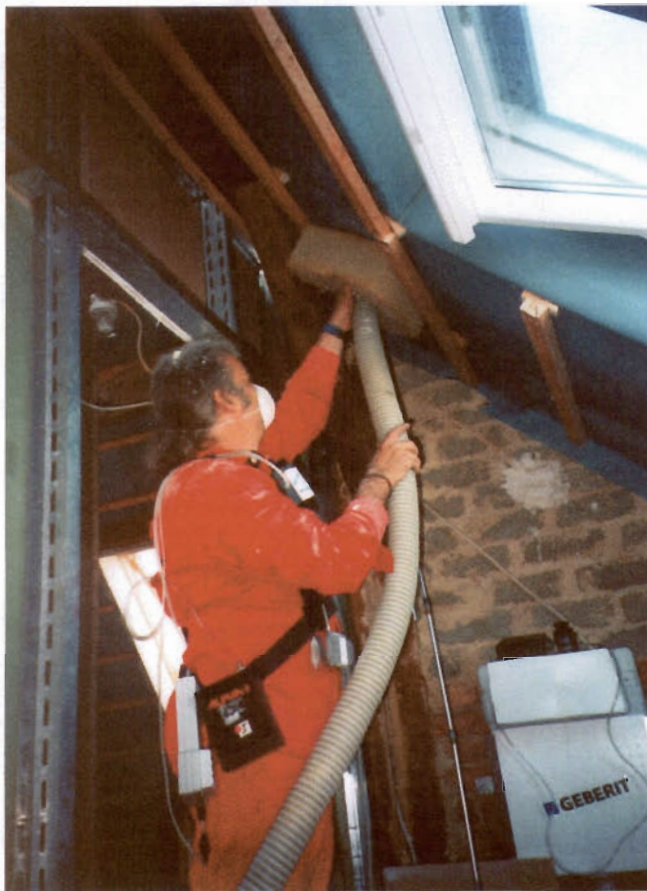
Bild 8: Einblasen von Holz-Dämmstoff Termoträ in vorbereitete Dach-Elemente
