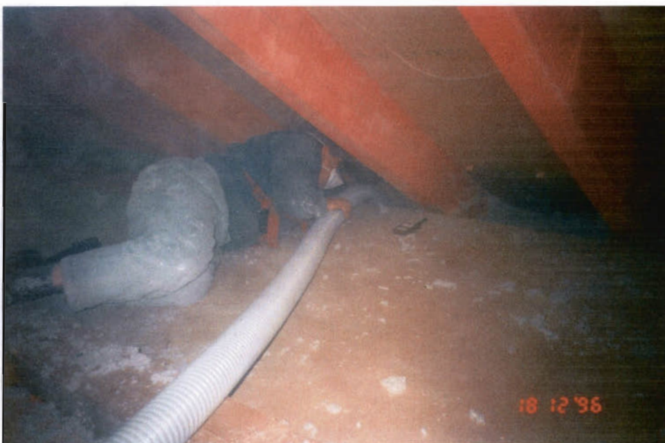
Bild 1: Einblasen von Zellulose-Dämmstoff (CWA) in die Flanken eines Steildaches
