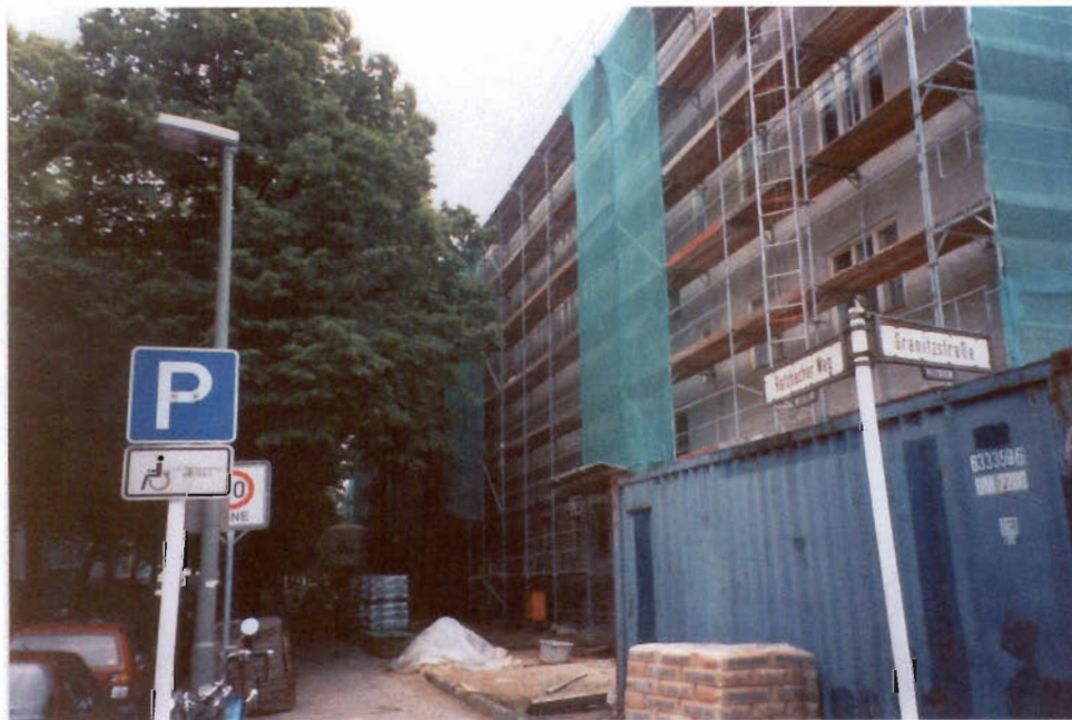
Bild 6: Blick auf die zu dämmenden Plattenbauten
