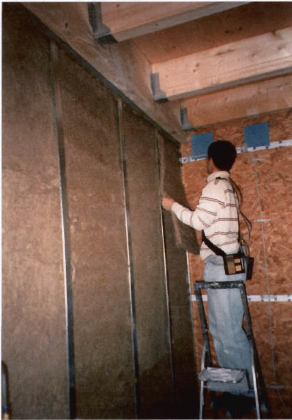
Bild 23: Einbau von Flachs-Matten in Aluminium-Ständerwände
