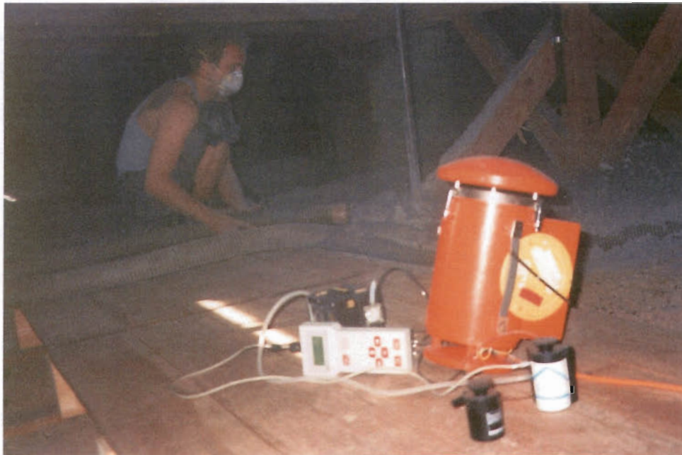
Bild 7: Offenes Aufblasen des Zellulose-Dämmstoffes, im Vordergrund befinden sich die Staub- und Faserprobenahmegeräte
