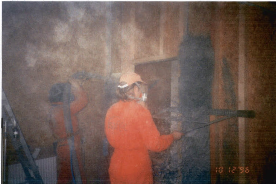
Bild 3: Oberflächenbündiges Abziehen mit einer Planbürste
