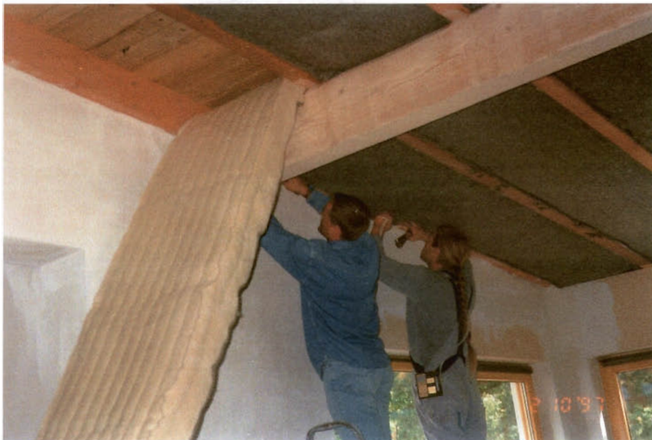
Bild 19: Einbau von Schafwolle-Matten zwischen die Deckensparren
