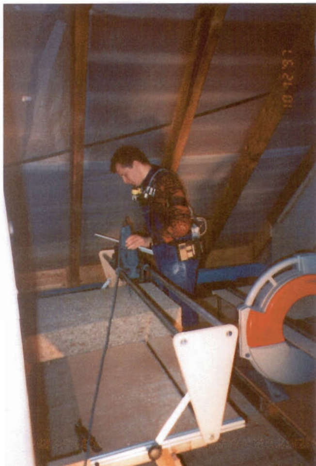
Bild 17: Zuschnitt der Zellulose-Platten mit einem Elektro-Fuchsschwanz
