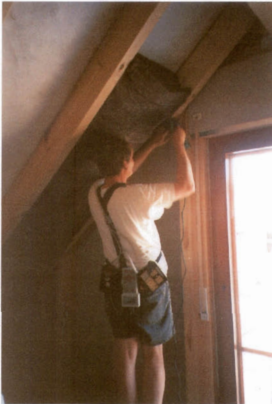
Bild 21: Einbau von Schafwolle-Platten zwischen die Dachsparren
