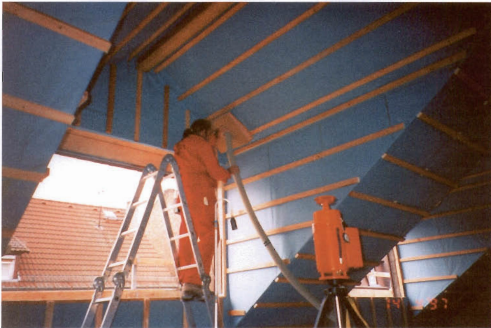
Bild 5: Einblasen von Zellulose-Dämmstoff (Isofloc-L) in vorbereitete Dach-Elemente
