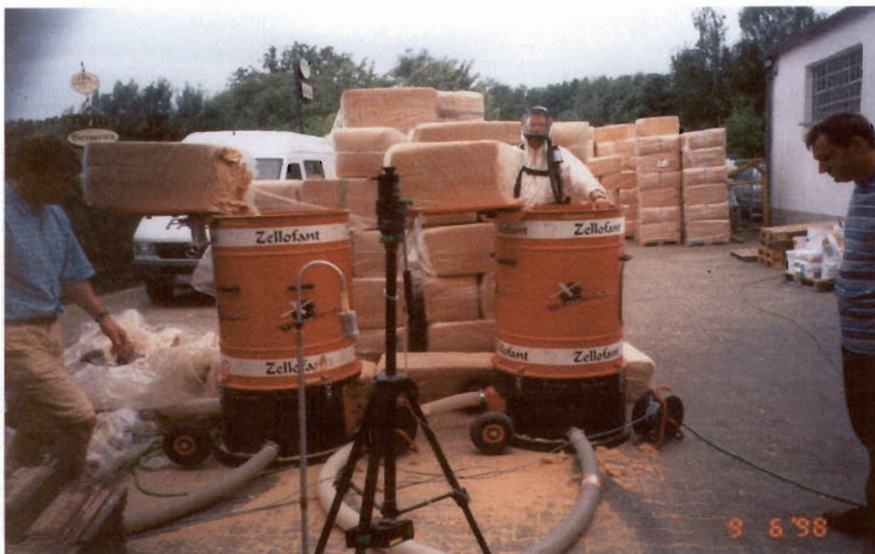
Bild 12: Befüllen der Einblasmaschinen
