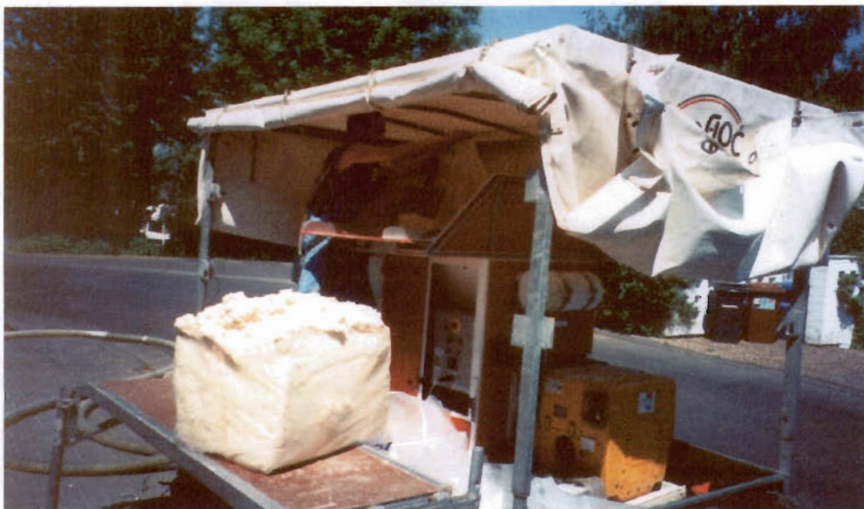
Bild 9: Befüllen der Einblasmachine mit Holz-Dämmstoff Termoträ
