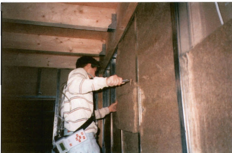
Bild 24: Schneiden von Flachs-Matten mit einem Messer
