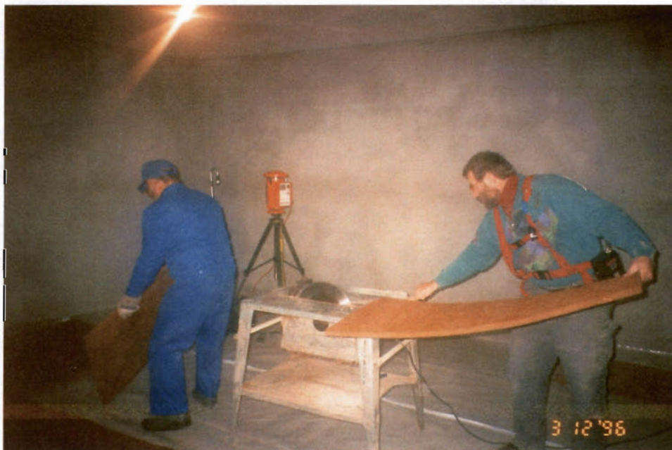
Bild 18: Einbau von Kokos-Estrichdämmplatten; Zuschnitt mit einer Kreissäge
