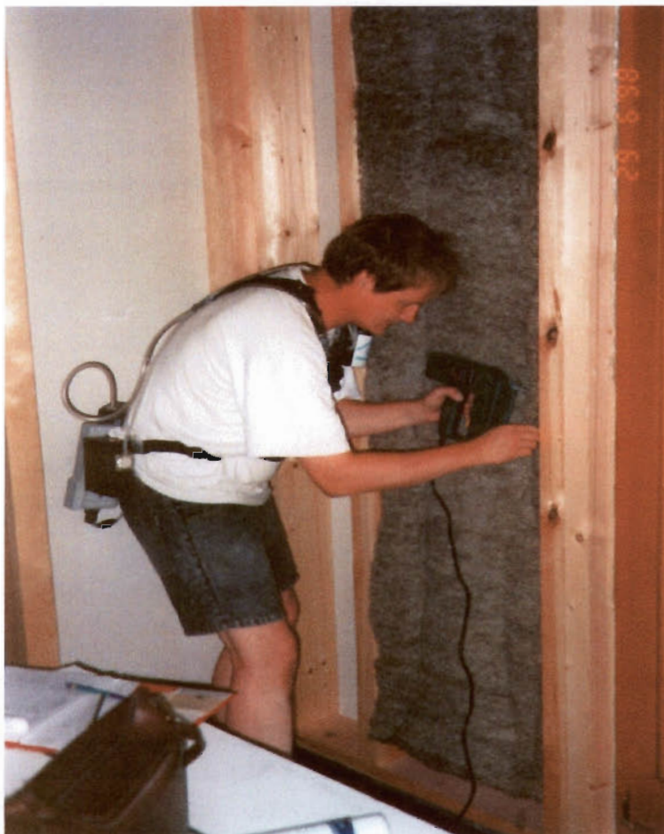
Bild 20: Einbau von Schafwolle-Matten in Innenwände
