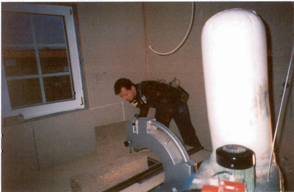
Bild 16: Zuschnitt der Zellulose-Platten mit einer abgesaugten Bandsäge
