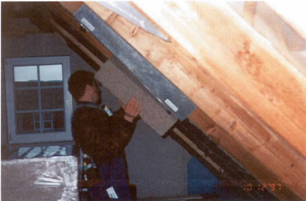
Bild 15: Einbau von vorkonfektionierten Zellulose-Platten
