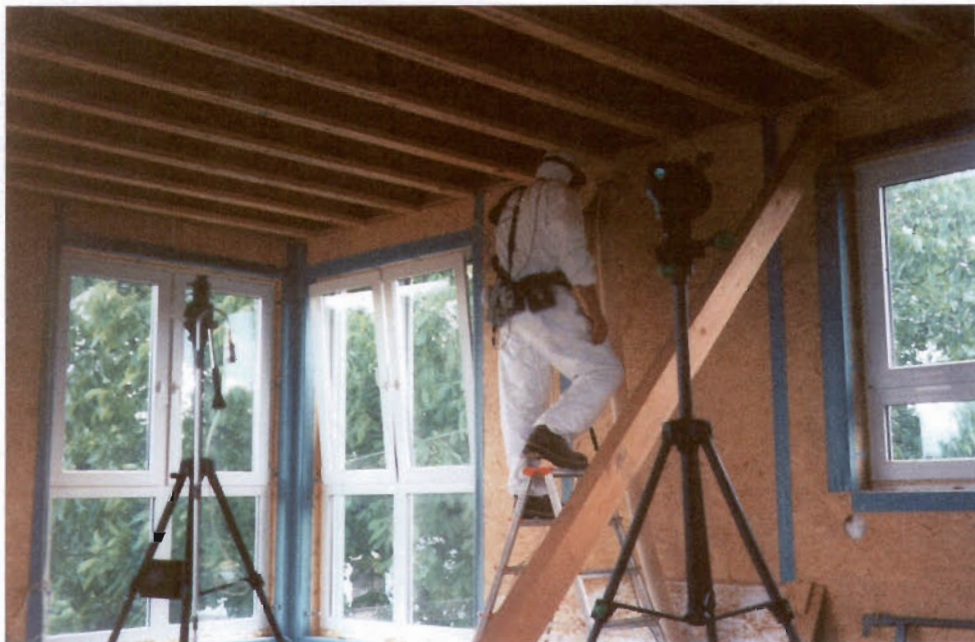
Bild 10: Einblasen von Holzdämmstoff in Wandelemente
