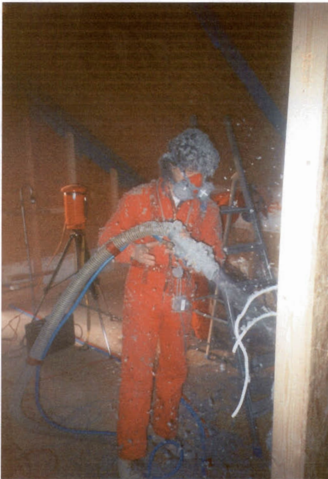
Bild 2: Aufblasen von Zellulosedämmstoff im CSO-Verfahren
