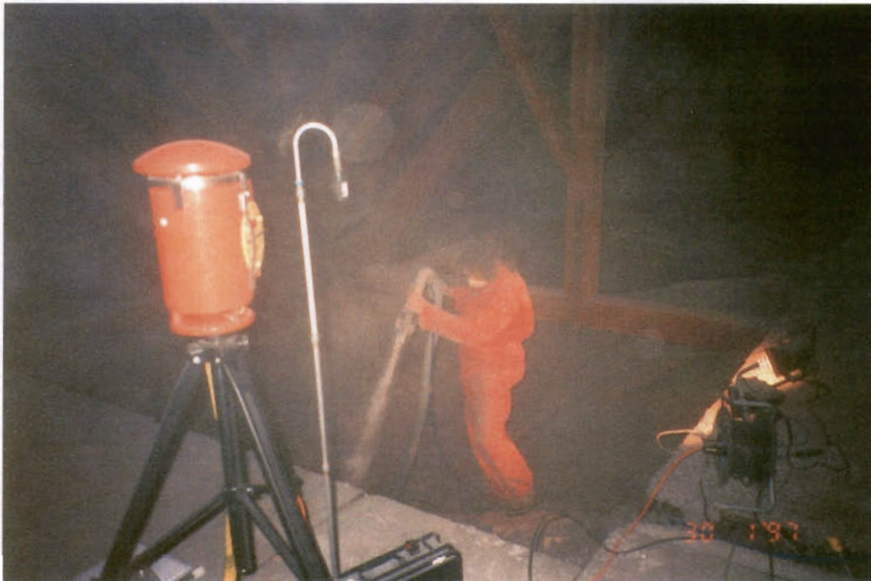
Bild 4: Aufblasen von Zellulose-Dämmstoff auf eine Kirchenkuppel
