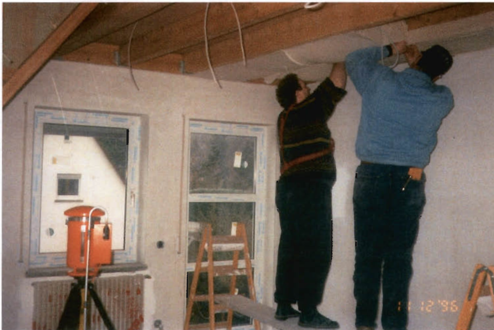
Bild 22: Einbau von Baumwolle-Matten zwischen die Deckensparren
