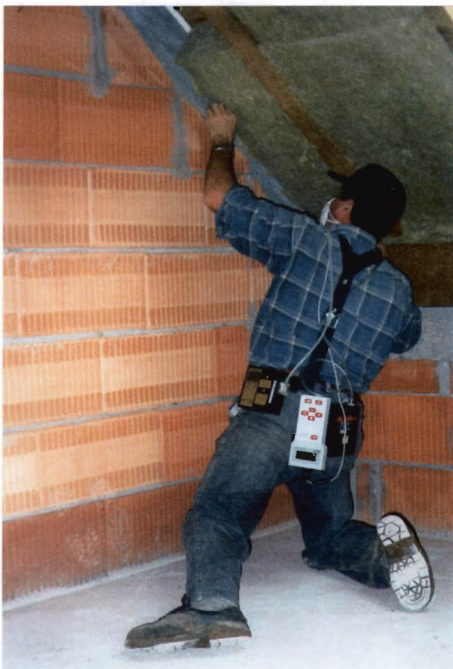
Bild 26: Einbau von Mineralwolle-Platten als Zwischensparrendämmung
