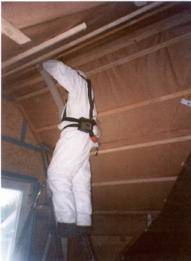
Bild 11: Einblasen von Holzdämmstoff in Dachelemente
