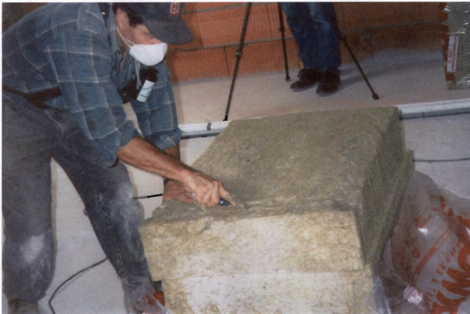
Bild 27: Schneiden der Mineralwolle-Platten mit einem Messer
