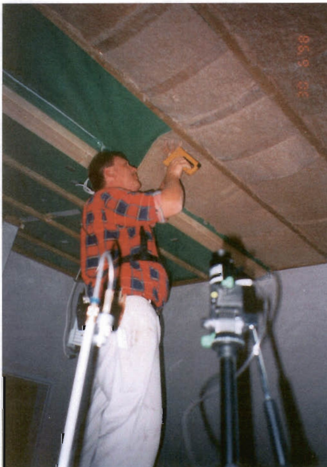
Bild 25: Einbau von Flachs-Matten in die Deckensparren, im Vordergrund sieht man stationäre Faser- und Staubmessgeräte
