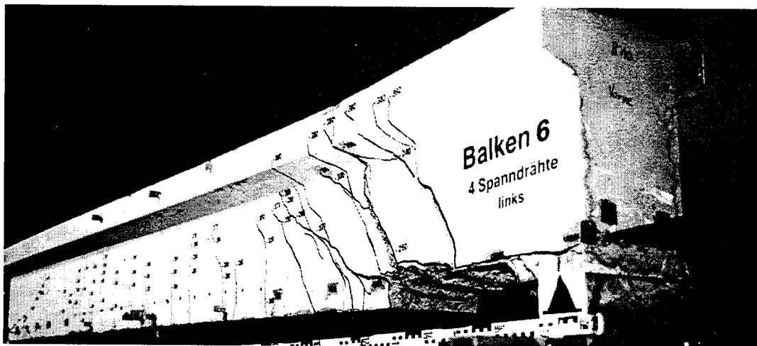
Bild 70: Rißbild im Bruchzustand für Balken 6
