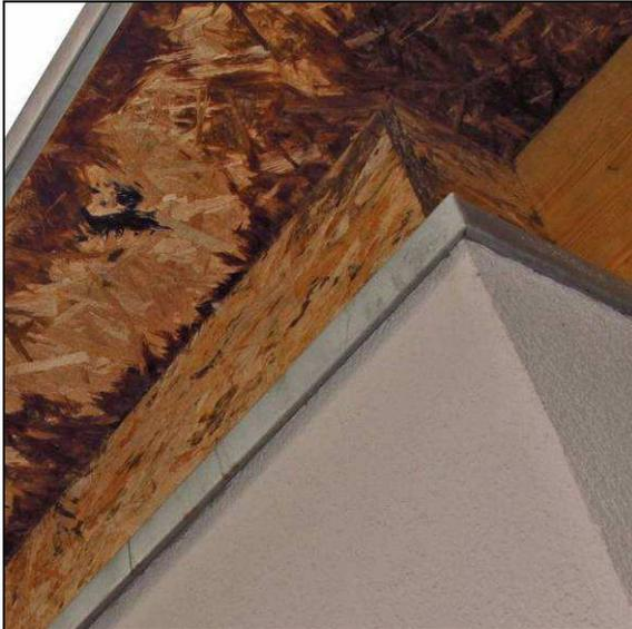
Abb. 32: Durchfeuchtungserscheinungen auf der Unterseite des Dachüberstandes
