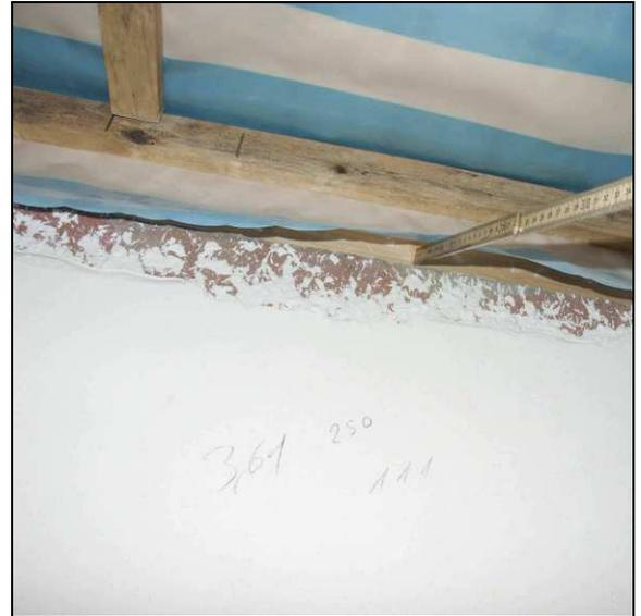
Abb. 18: Keine Verbindung der Dampfsperre zu verputzter Mauerwerksfläche (Außenwand)
