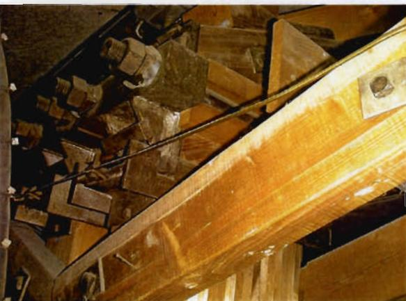
**Bild D-35c:** besichtigtes Bauwerk Nr. 15 (Objektbereich 15.1); Detailaufnahme des Auflagerbereiches mit Stirnplatten-Details zum Anschluß der Zugbandkräfte
