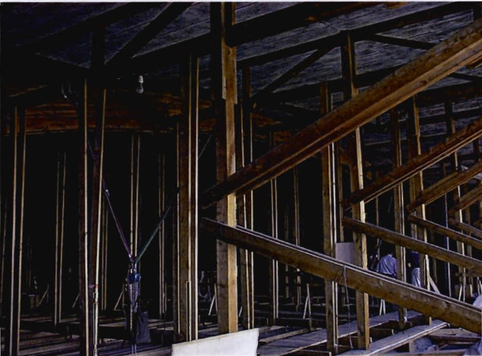
**Bild D-33b:** besichtigtes Bauwerk Nr. 15; Ansicht des Dachinnenraumes (Objektbereich 15.1) und der konstruktiven Ausführung der Deckenabhängung
