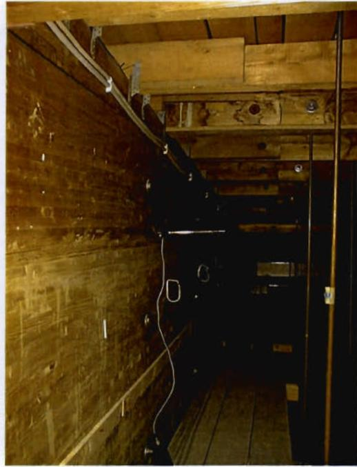
**Bild D-66a,b:** besichtigtes Bauwerk Nr. 30; Ansicht eines begutachteten BSH-Trägers mittels eines stationären Laufstegs für Bauwerkskontrollen
