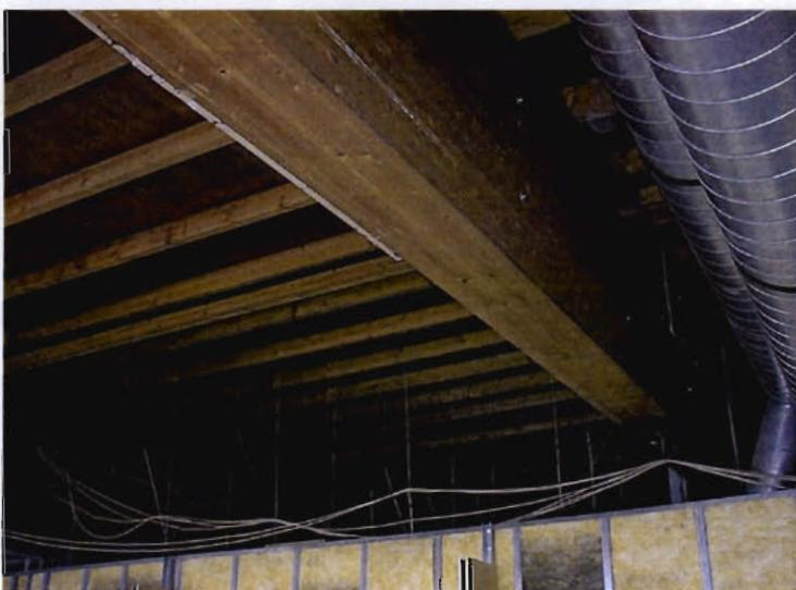
**Bild D-65c:** besichtigtes Bauwerk Nr. 30; Ansicht eines BSH-Satteldachträgers (Kastenquerschnitt)
