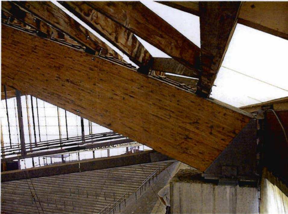
**Bild D-38a:** besichtigtes Bauwerk Nr. 16; Ansicht eines BSH-Bogenträger-Auflagerbereiches
