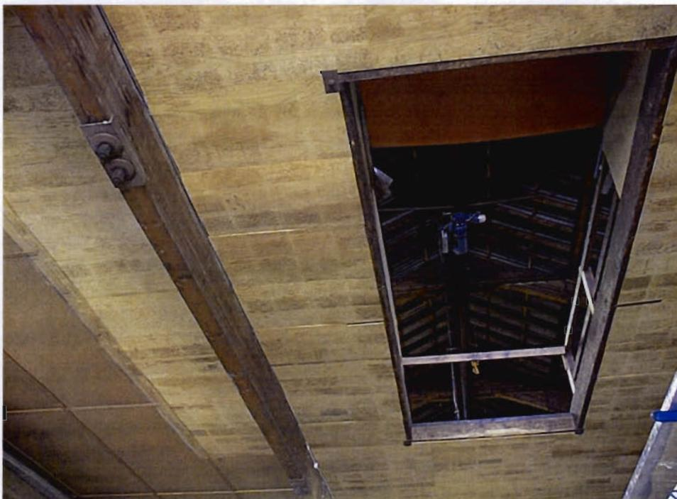
**Bild D-46b:** besichtigtes Bauwerk Nr. 19 (Objektbereich 19.2); Untere Deckenansicht über dem als Lagerraum genutzten EG; das Bild zeigt die Befestigung der BSH-Unterzüge an den Stahlstangenabhängern
