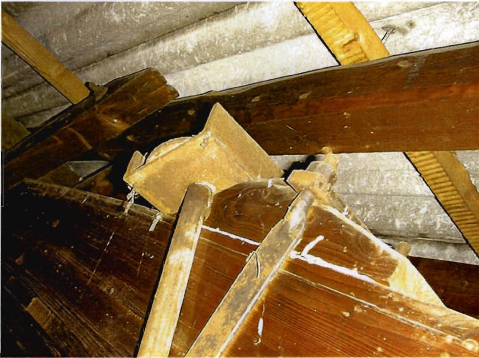
**Bild D-46a:** besichtigtes Bauwerk Nr. 19 (Objektbereich 19.1); Detail der Lasteinleitung der Stahlstangengehänge zur Befestigung der abgehängten Decke; vgl. Bild D-46b
