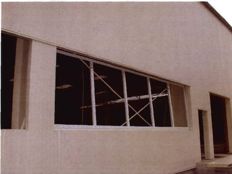
Abbildung 4-3: Windverband direkt vor einer Fensteröffnung
