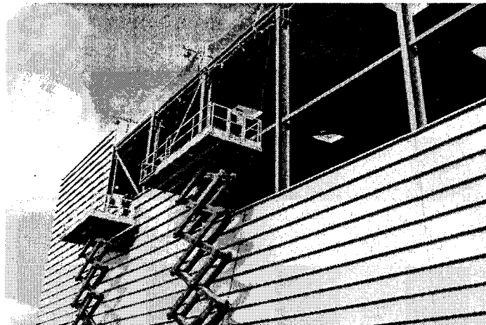
Bild 4.2-6: Montage der Kassetten-Innenschale
