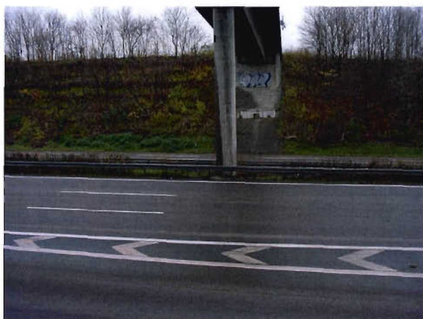
Bild 3.10-1 Nördliches Widerlager der Feldwegüberführung
