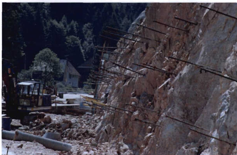
Bild 3.9-1 Verankerte Felsböschung
