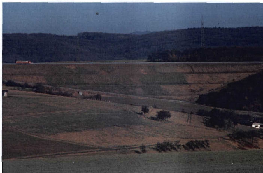
Bild 3.2-1 Ansicht des Bengener Dammes im Jahr 1980
