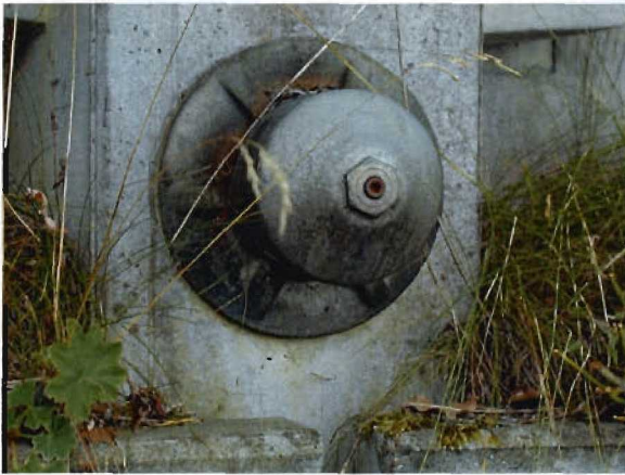
Bild 3.1-13 Verzinkter Lisenenankerkopf (Einstabanker)
