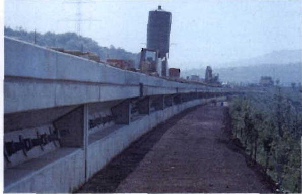
Bild 3.2-6 Pfehlkopfbalken mit Ankern (1985)
