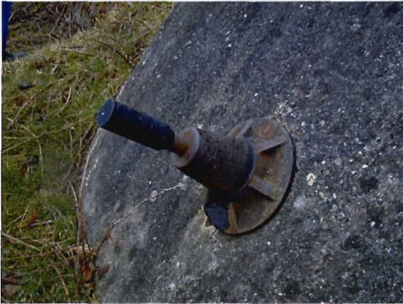
Bild 3.4-3 Ankerkopf, Kappe mit Gewinde
