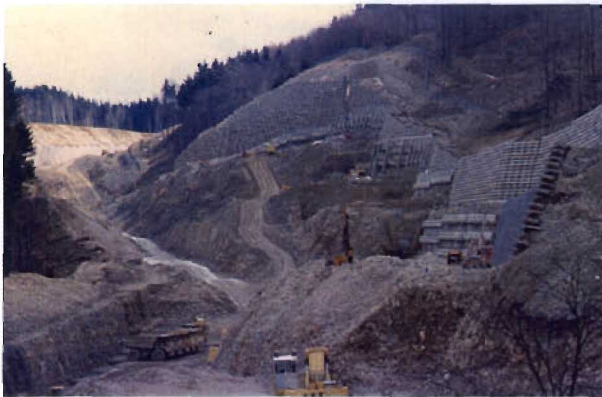
Bild 3.1-1 Ansicht des Einschnittes von Norden (1985)
