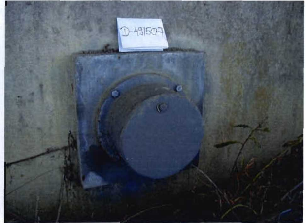
Bild 3.1-27 Ankerkopf in relativ gutem Zustand
