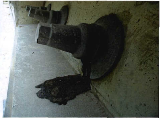
Bild 3.2-12 Austritt von Korrosionsschutzmasse Bild 3.2.-13 Austritt von Korrosionsschutzmasse
