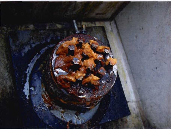
Bild 3.3-9 Korrosionsschutz unter der Kappe
