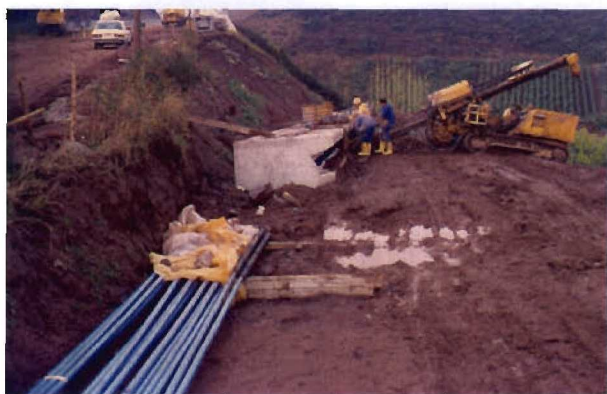
Bild 3.5-4 Kopfbalken während der Ausführung der Verankerung
