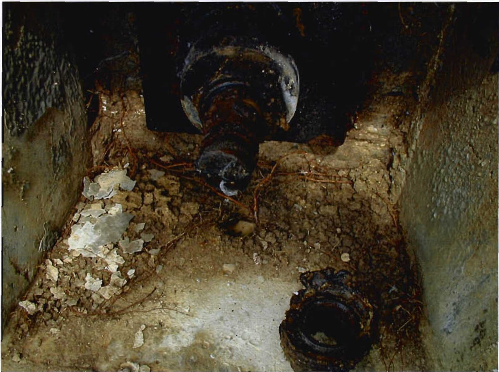
Bild 3.6-13 Kopf eines Einstabankers (MeßBankers)
