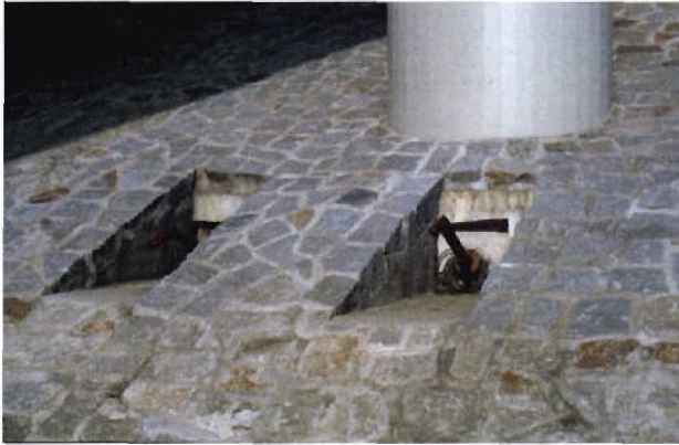
Bild 3.7-9 Zwei Anker im Kopfbalken (1990)
