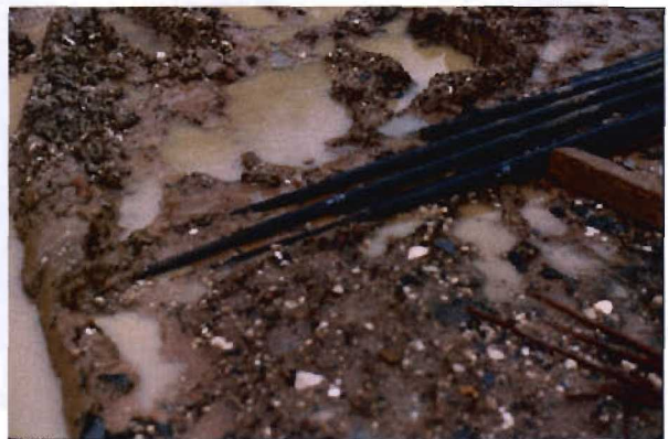
Bild 4-2 Nicht fachgerechte Ankerlagerung
