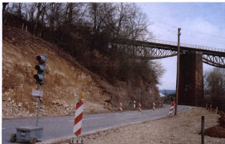
Bild 3.8-2 Zu verankernde Felsböschung vor dem Abtrag
