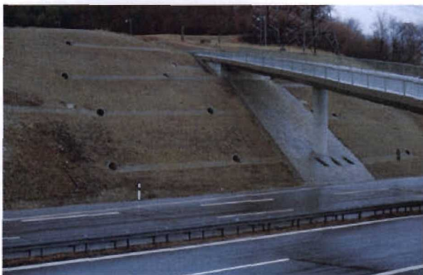
Bild 3.7-6 Überschüttete verankerte Böschung mit Kontrollankern
