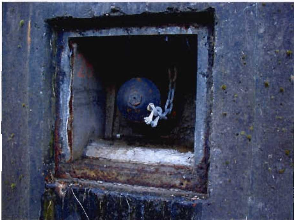
Bild 3.9-11 Ankerkopf (2002)
