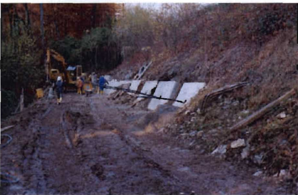
Bild 3.13-3 Baustelle während der Ankerarbeiten
