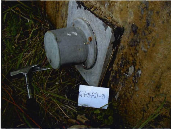
Bild 3.1-26 Ankerkopf in relativ gutem Zustand
