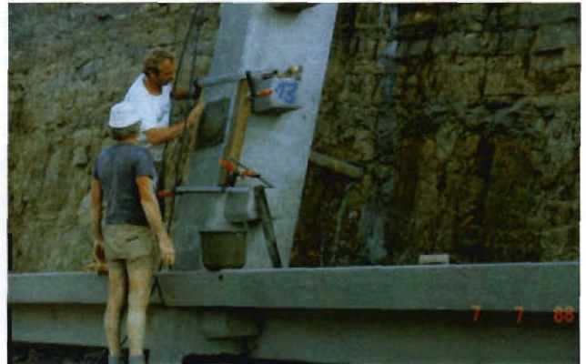
Bild 3.14-9 Verschuß eines Pfahlkopfes, Futtermauer am Westportal des Rollenbergtunnels
