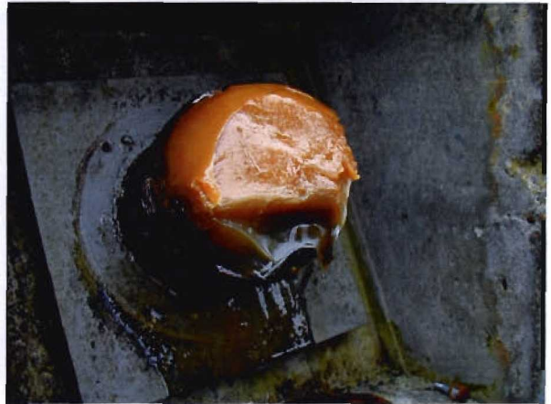
Bild 3.3-12 Korrosionsschutz unter der Kappe
