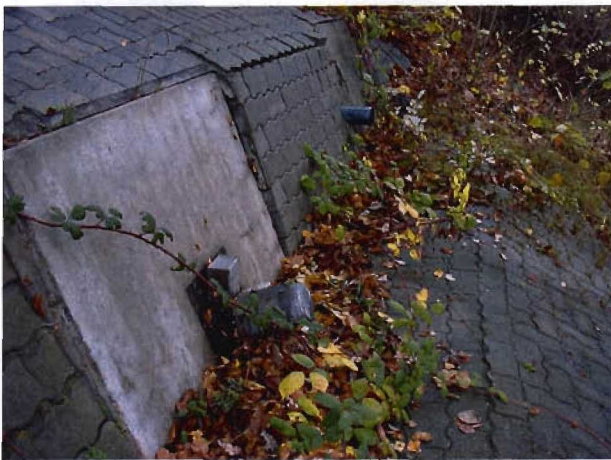
Bild 3.10-5 Anker am südlichen Widerlager
