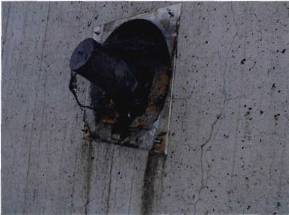
Bild 3.6-19 Zusatzanker nach Abnahme der Blechhaube
