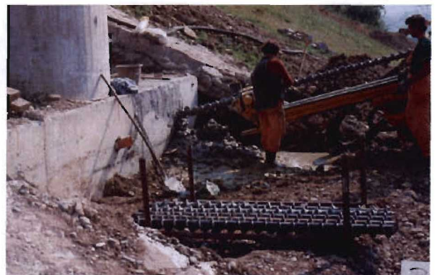
Bild 3.7-8 Bohren der Löcher für die Verankerung des Pfeilerkopfbalkens
