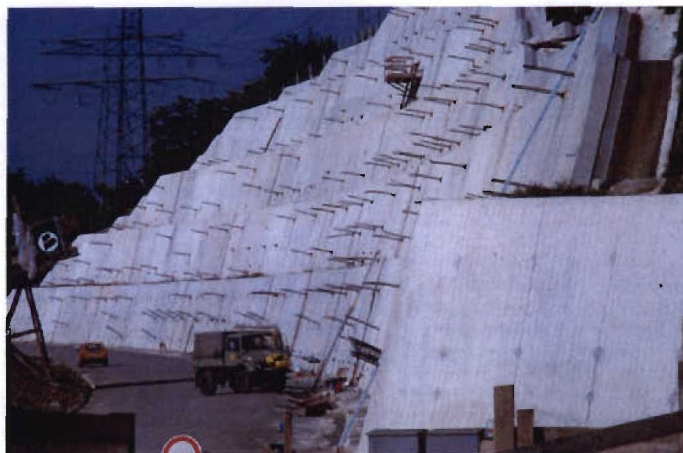
Bild 3.6-6 Wand mit Zusatzankern im Jahr 1984
