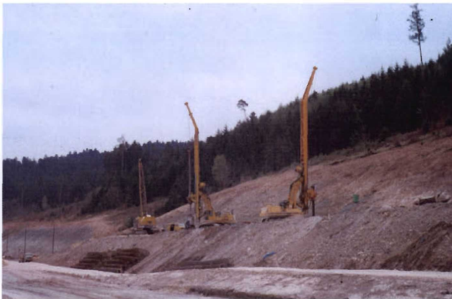
Bild 3.3-1 Blick auf die Anschnittböschung
