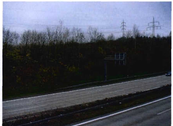
Bild 3.11-2 Verankerung in der südlichen Einschnittböschung westlich der AS Wendlingen (Aufnahmedatum: November 2002)
