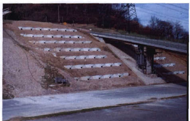
Bild 3.7-3 Verankerung nach Fertigstellung
