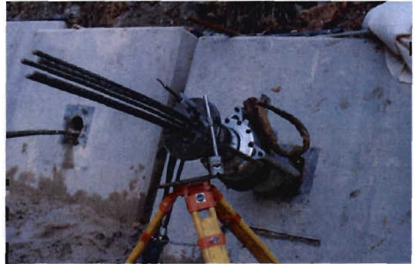
Bild 3.13-4 Prüfung eines Ankers
