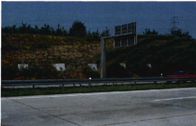
Bild 3.11-1 Verankerung in der südlichen Einschnittböschung westlich der AS Wendlingen (Aufnahmedatum: 1982)
