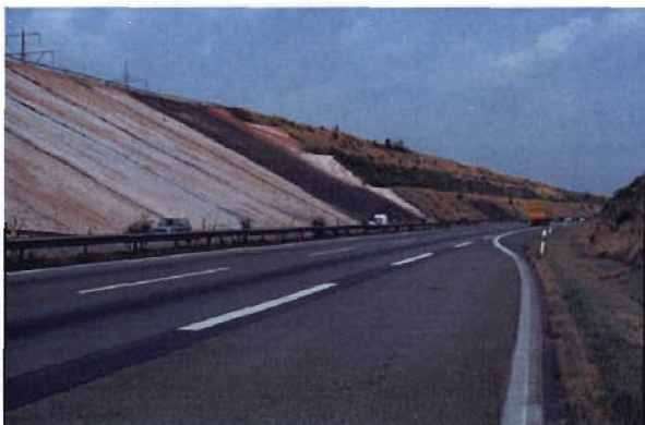
Bild 3.2-7 Einschnittböschung während der Sanierung
