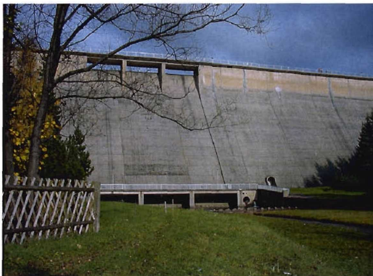
Bild 3.15-2 Talsperre Rauschenbach, HW-Entlastung
