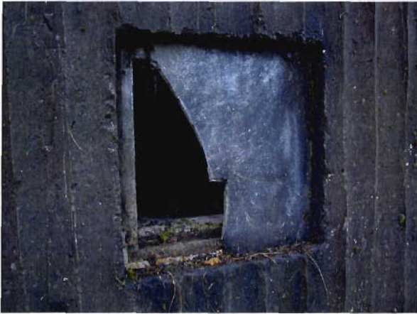
Bild 3.9-9 Zerstörte Faserzementplatte
