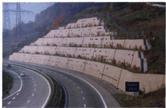
Bild 3.6-3 Ansicht der Stützmauer (1986)
