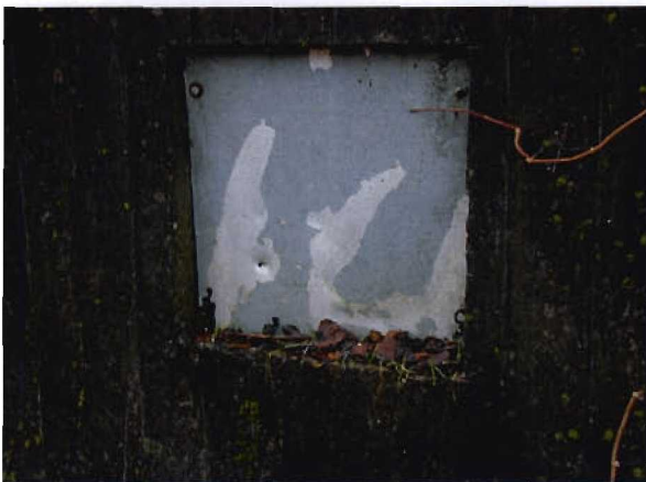
Bild 3.9-7 Kappe, offensichtlich mit Schussbeschädigung
