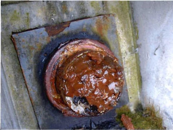
Bild 3.3-11 Korrosionsschutz unter der Kappe
