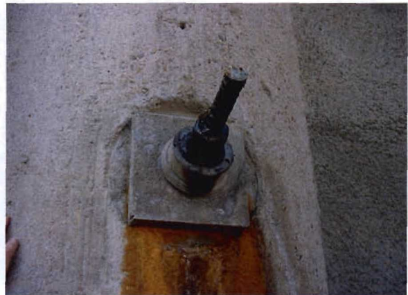
Bild 4-6 Möglicherweise aggressives Wasser am Ankerkopf
