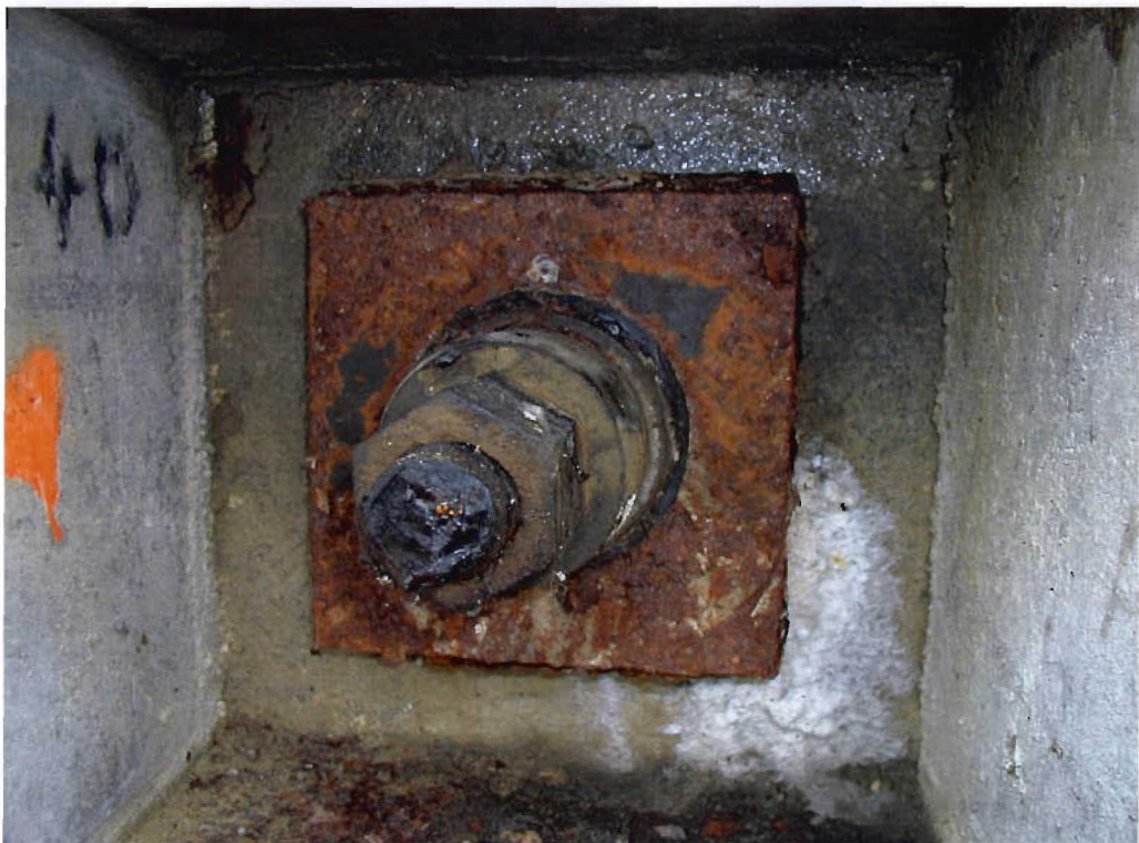
Bild 3.6-14 Kopf eines Einstabankers (MeßBankers)
