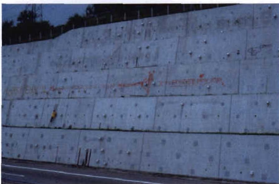
Bild 3.6-2 Ansicht der Stützmauer (1984)
