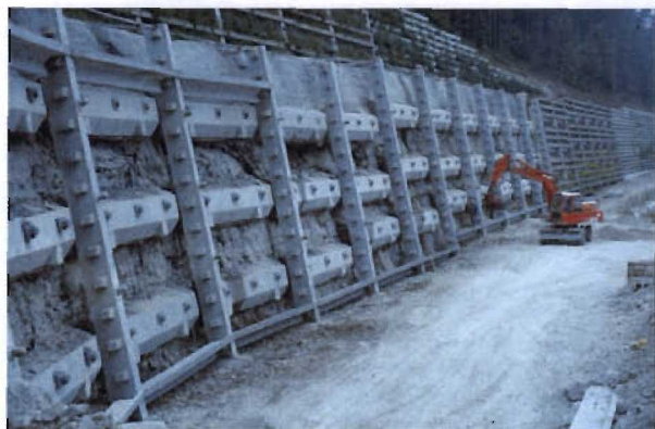
Bild 3.1-4 Zusatzverankerung während der Bauzeit Bild 3.1-5 Spannen von Zusatzankern
