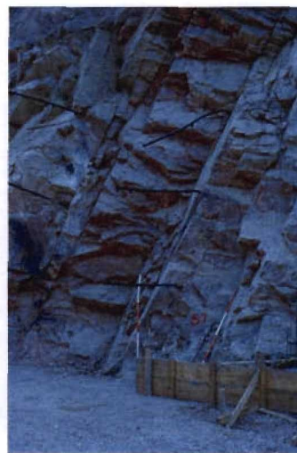
Bild 3.9-2 Verbogene Anker
