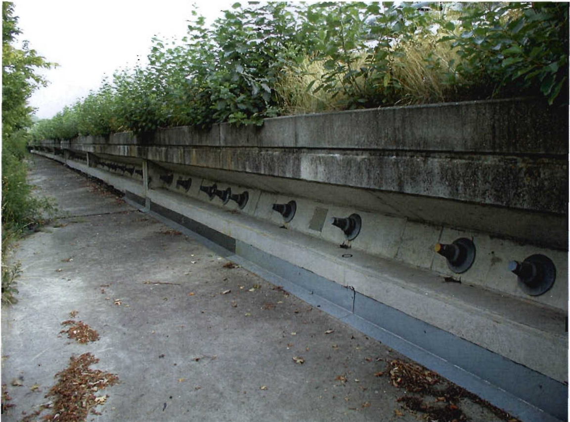
Bild 3.2-9 Kopfbalken und Unterhaltungsweg (2001)
