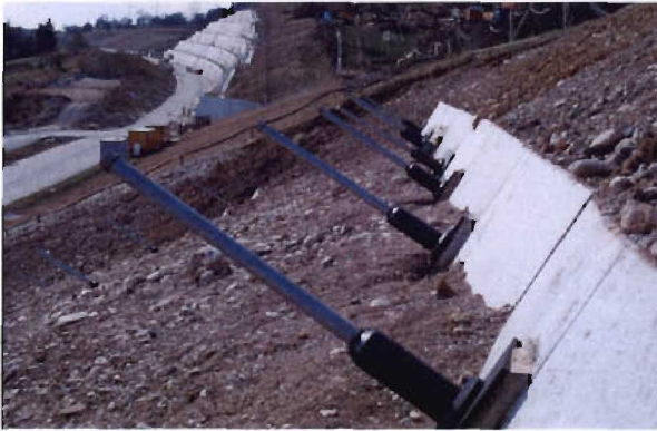
Bild 3.7-4 Ankerreihe mit Stahlüberstand zur Ankerkraftregulierung
