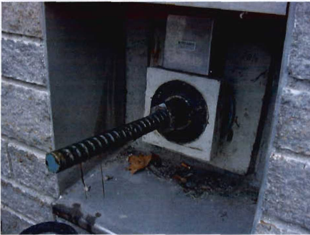
Bild 3.12-7 Stahlüberstand und Anker Mutter
