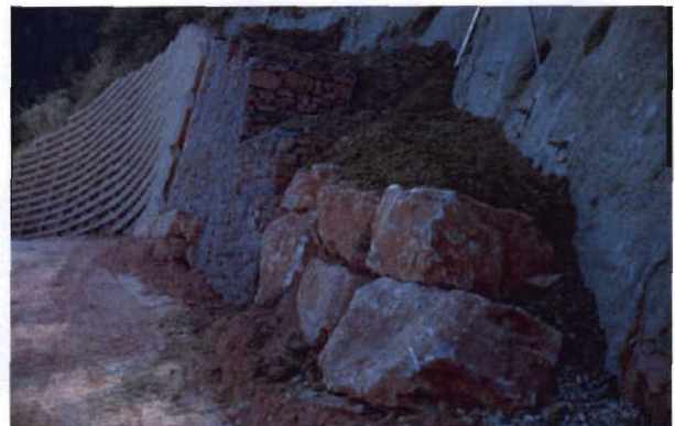
Bild 3.14-3 Randabschluß der Mauer
