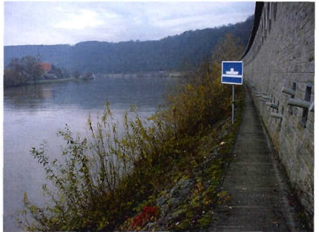
Bild 3.12-2 Stützmauer Haßmersheim, Blick neckarabwärts
