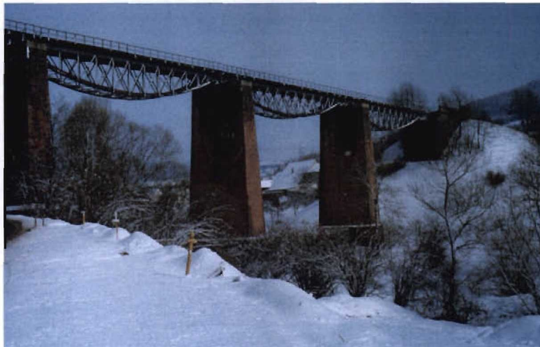
Bild 3.9-1 Brücke der Sauschwänzlebahn bei Fützen
