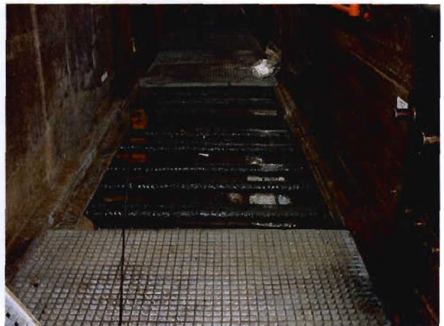
Bild 3.15-4 Blick in den Kontrollgang, Spannglieder unter der Abdeckung
