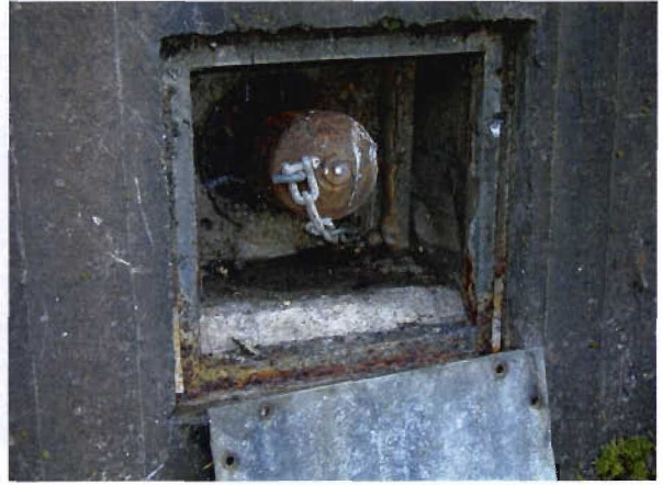
Bild 3.9-14 Ankerkopf (2002)
