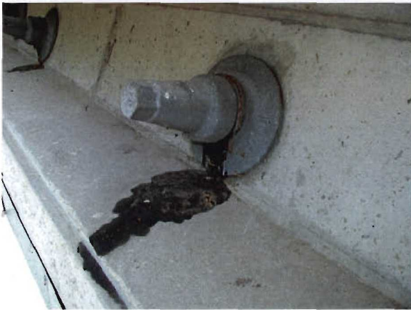
Bild 3.2-14 Anker vor dem Entfernen der Abdeckkappe
