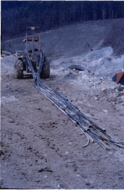
Bild 4-3 Nicht fachgerechter Ankertransport
