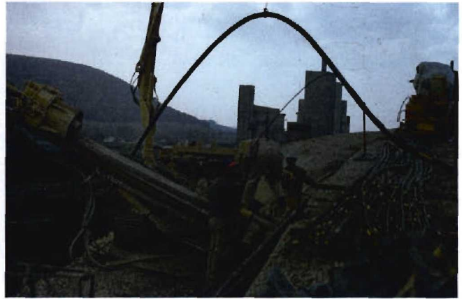
Bild 4-4 Nicht fachgerechter Einbau mit Würgeschlinge
