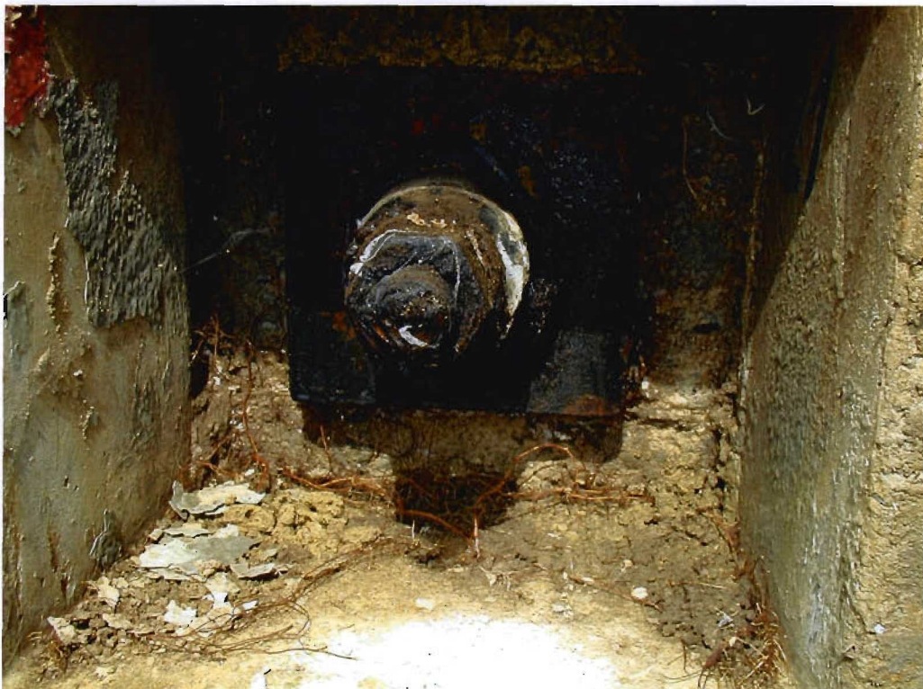
Bild 3.6-11 Kopf eines Einstabankers (Meßankers)
