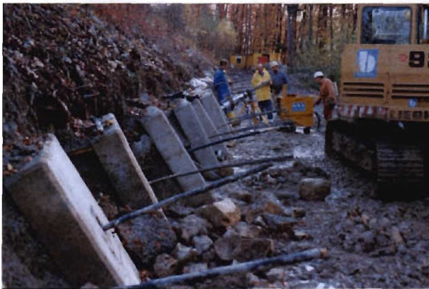
Bild 3.13-7 Anpassung der Platten an die Böschungsoberfläche
