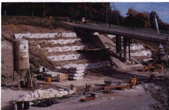
Bild 3.7-2 Blick auf den Widerlagerbereich während der Ankerarbeiten
