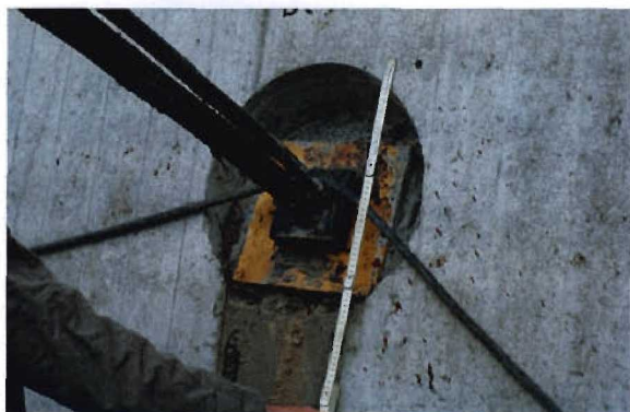
Bild 3.6-7 Zusatzanker (1983)
