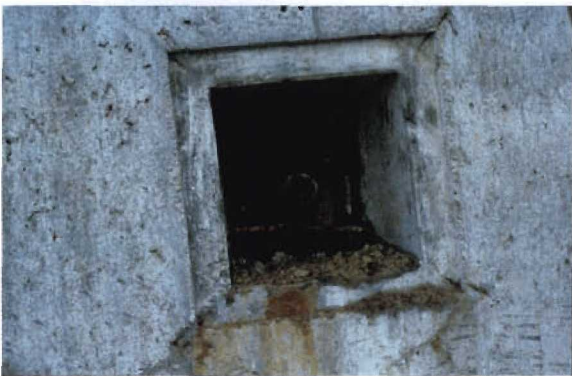
Bild 3.6-4 Kopf eines Meßanker im Jahr 1984
