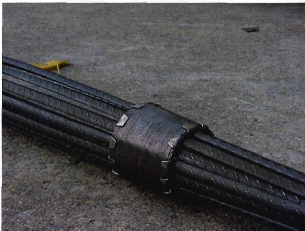
Bild 3.15-3 Bündelspannglied BSG 100 mit Manschette
