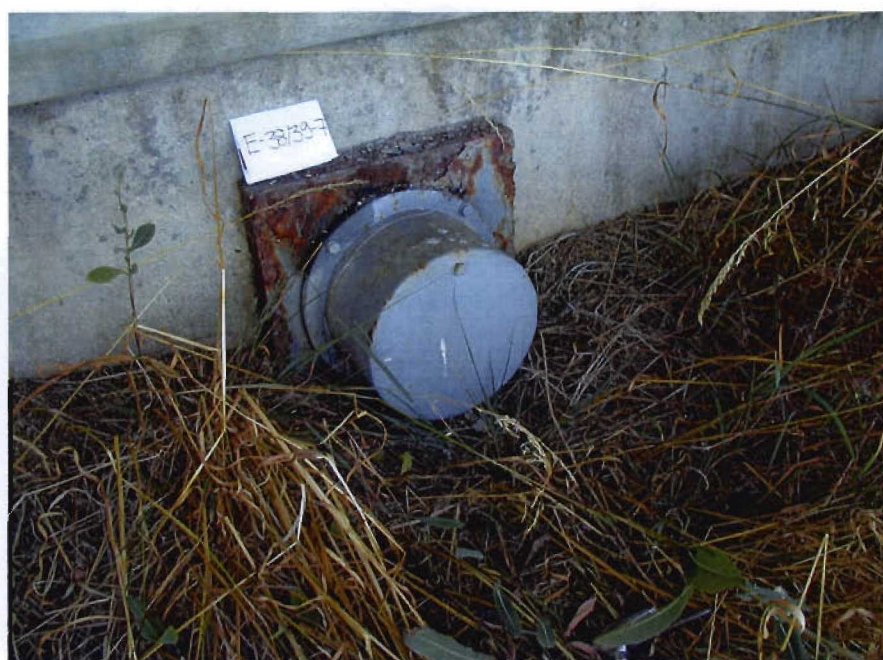
Bild 3.1-25 Rostangriff am Ankerkopf
