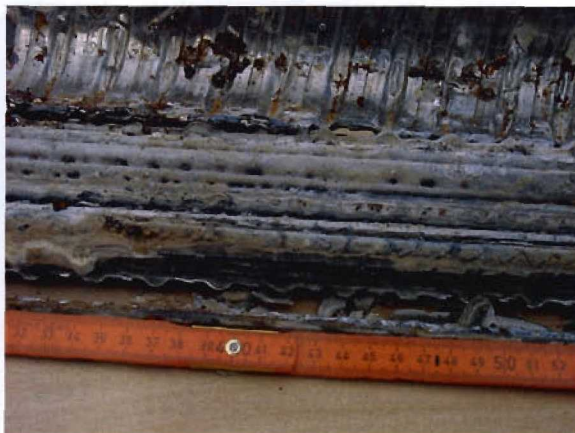
Bild 3.15-6 Spannglied nach Abnahme des Hüllrohres
