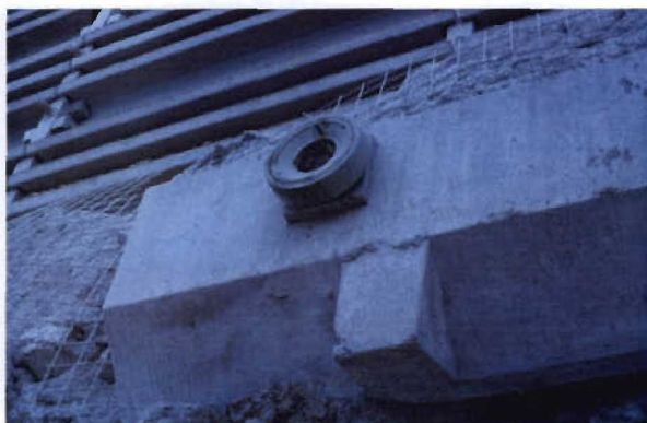
Bild 3.1-7 Abhebepresse auf einem Betonriegel der Zusatzverankerung
