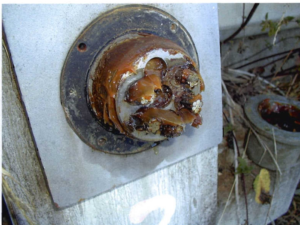
Bilder 3.1-20 Anker E-38-u nach Abnahme der Kappe
