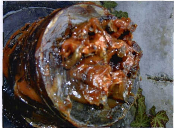
Bild 3.3-8 Korrosionsschutz unter der Kappe
