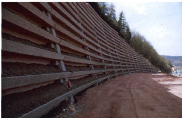
Bild 3.14-2 Obere Mauerböschung vor der Bepflanzung
