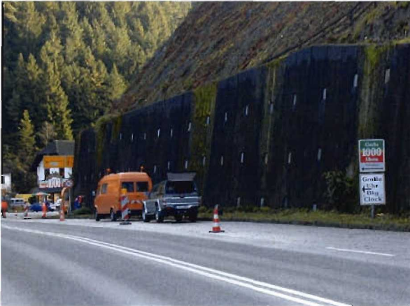
Bild 3.9-5 Stützmauer an der B 33 in Triberg
