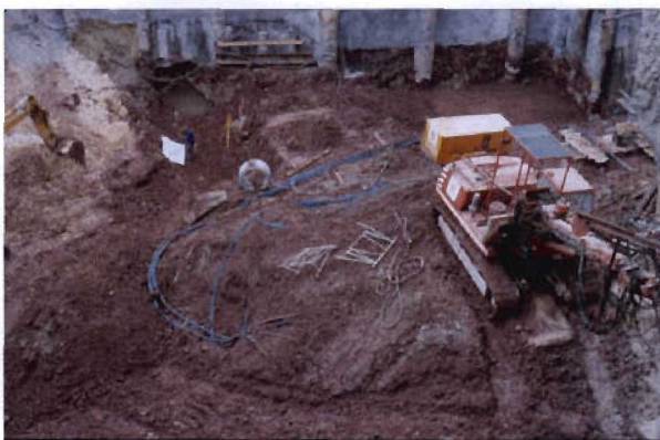
Bild 4-1 Nicht fachgerechte Ankerlagerung
