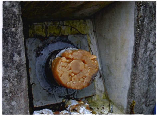
Bild 3.3-10 Korrosionsschutz unter der Kappe
