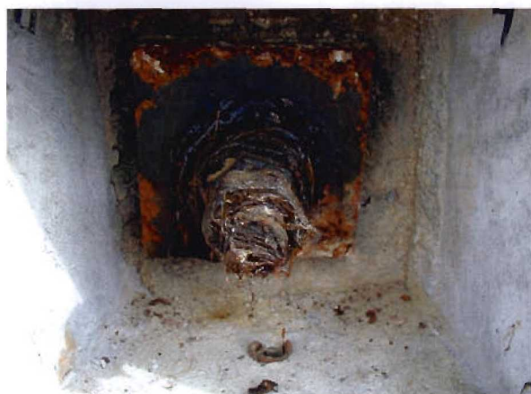
Bild 3.6-9 Kopf eines Einstabankers (Meßankers)
