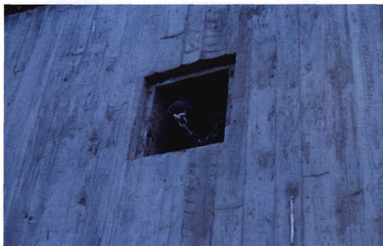
Bild 3.9-3 Mit Kettenstück gesicherter Ankerkopf
