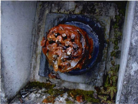
Bild 3.3-7 Korrosionsschutz unter der Kappe
