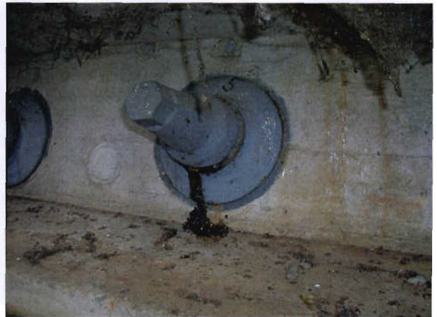
Bild 3.5-9 Ausgetretene Korrosionsschutzpaste
