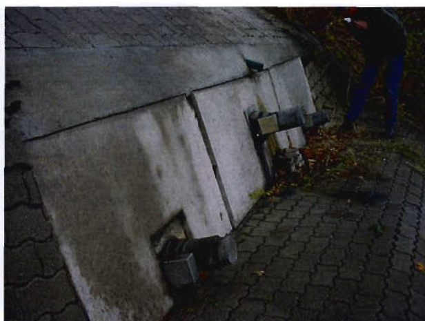
Bild 3.10-2 Anker in der Böschung unterhalb des Widerlagers
