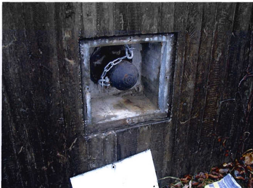
Bild 3.8-6 Ankerkopf mit Kettensicherung
