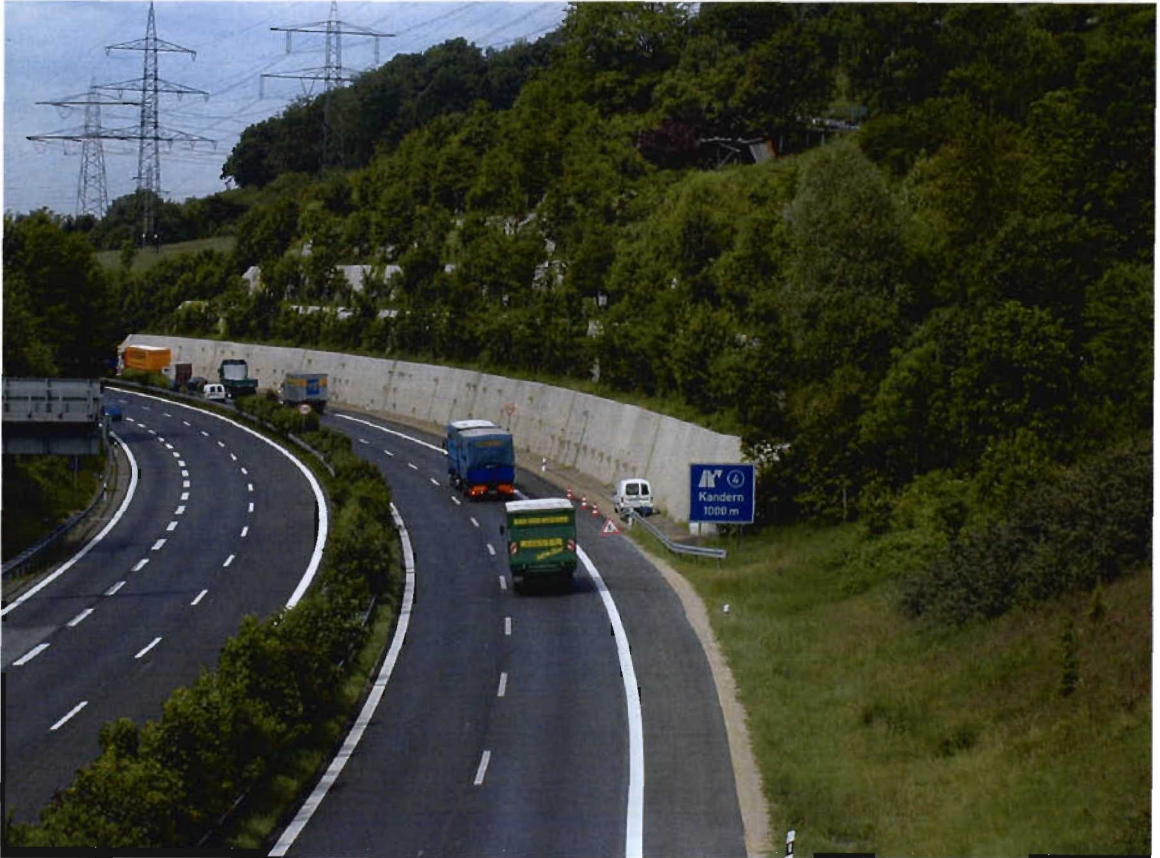
Bild 3.6-21 Blick auf die Stützmauer Rötteln im Jahr 2002
