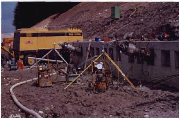
Bild 3.3-3 Spannarbeiten an den Anker
