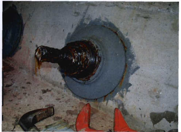
Bild 3.5-7 Ankerkopf mit abgenommener Kappe
