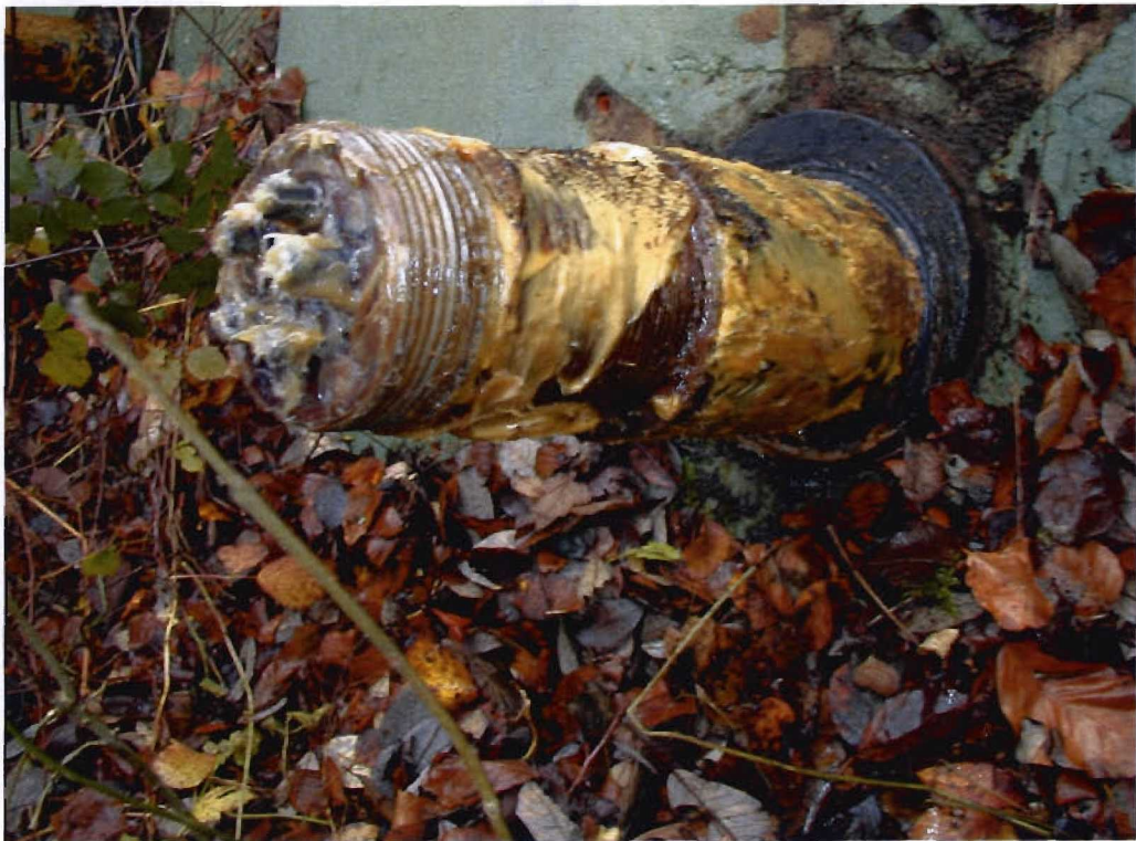
Bild 3.13-12 Keilträger mit Korrosionsschutz
