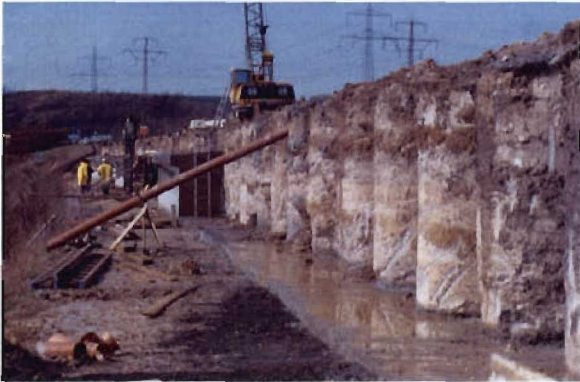
Bilder 32-5 Bohrpfähle am Böschungskopf
