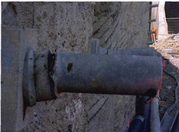
Bild 4-5 Beschädigter Ankerkopf
