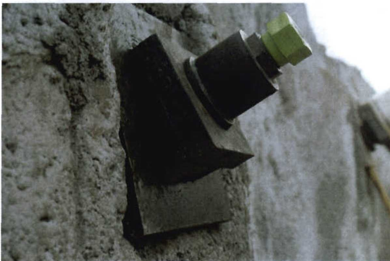
Bild 4-16 Ankerkopf mit Klötzchenauflagerung (Fotos 4-16 und 4-17. Dipl.-Ing. Meiniger)
