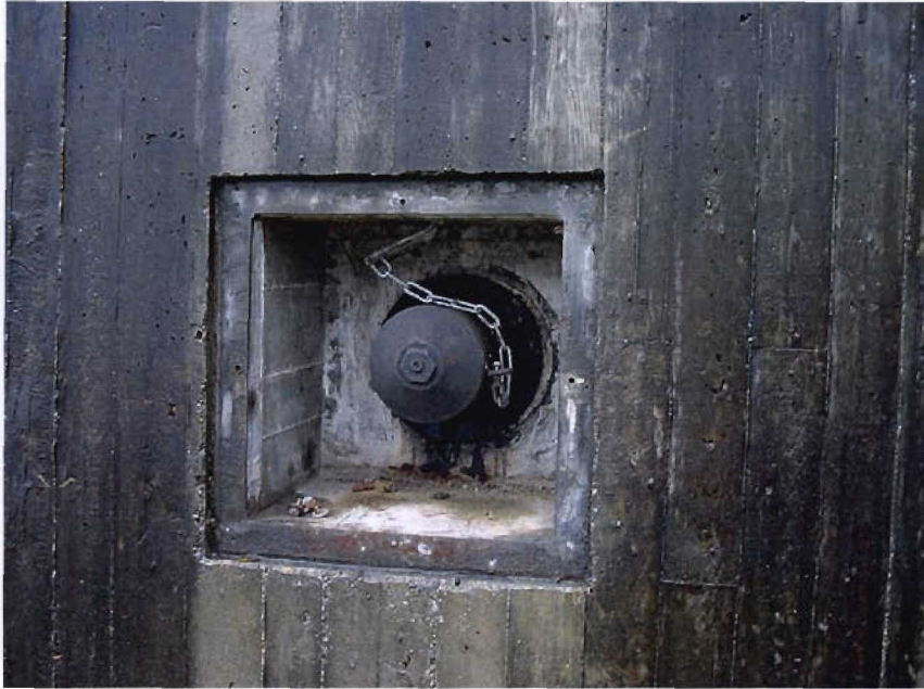
Bild 3.8-5 Ankerkopf mit Kettensicherung
