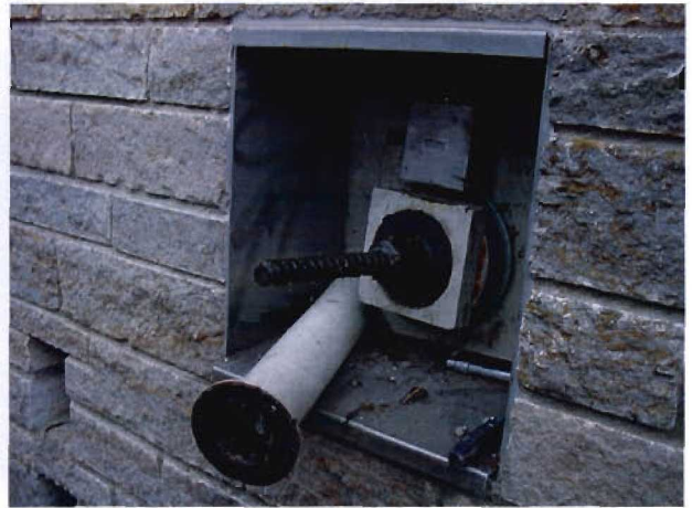
Bild 3.12-8 Stahlüberstand und Anker Mutter
