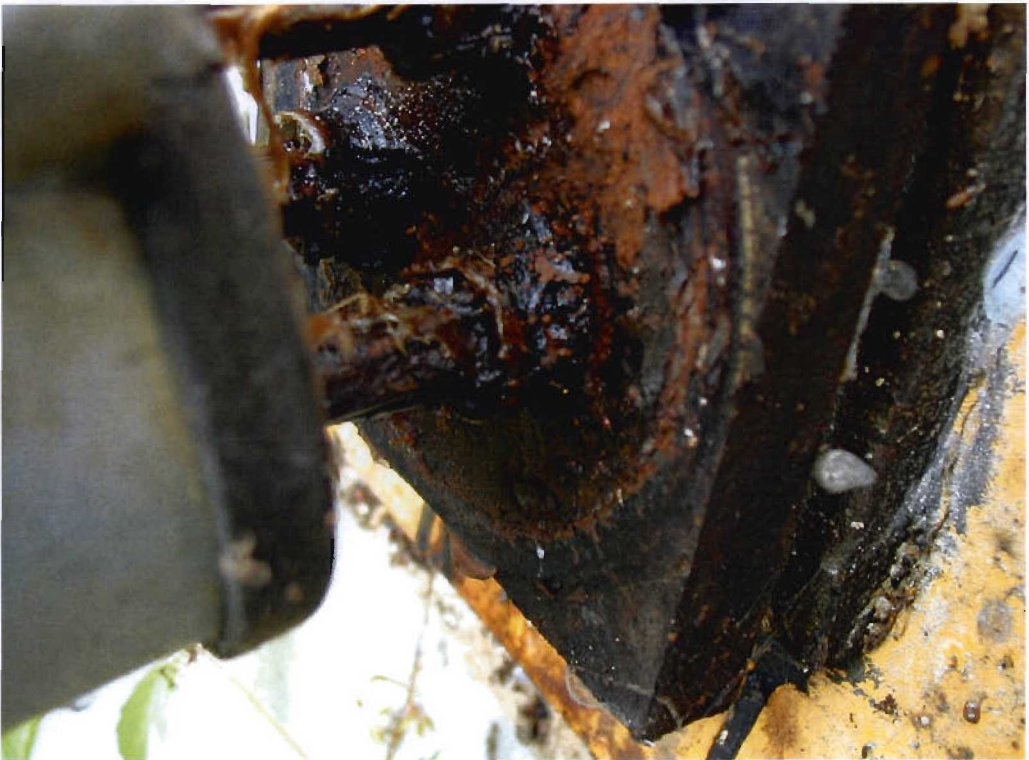
Bild 3.6-16 Zusatzanker nach Abnahme der Ankerkappe
