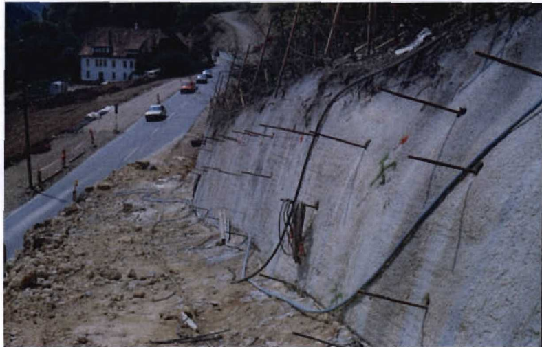
Bild 3.8-3 Anker und temporäre Spritzbetonsicherung
