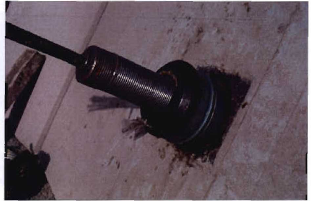
Bild 3.7-5 Kopf eines regulierbaren Dauerankers mit Stellmutter
