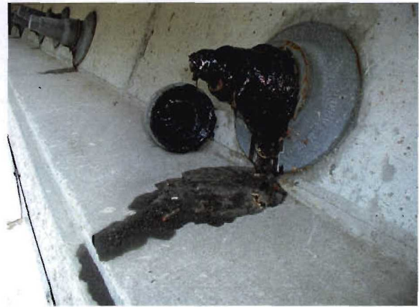
Bild 3.2-15 Anker nach dem Entfernen der Abdeckkappe
