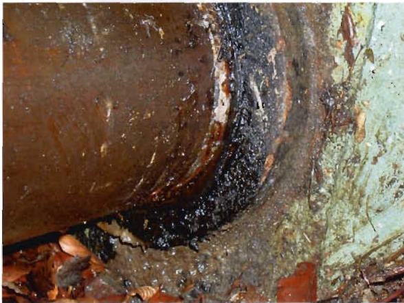
Bild 3.13-13 Korrosionsschutzpaste an der Dichtung der Ankerkappe
