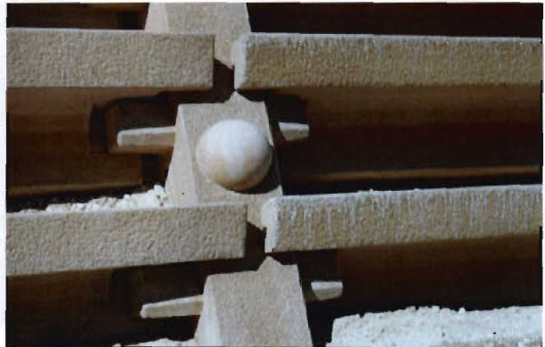
Bild 3.14-11 Verschlusener Pfahlkopf, Mauer an der B 14 (Stuttgart-Heslach)
