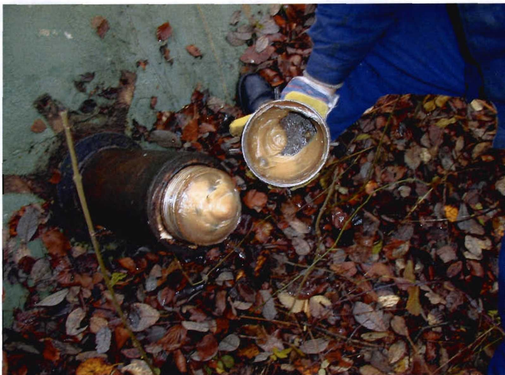
Bild 3.13-10 Korrosionsschutzpaste im Kappenkopf
