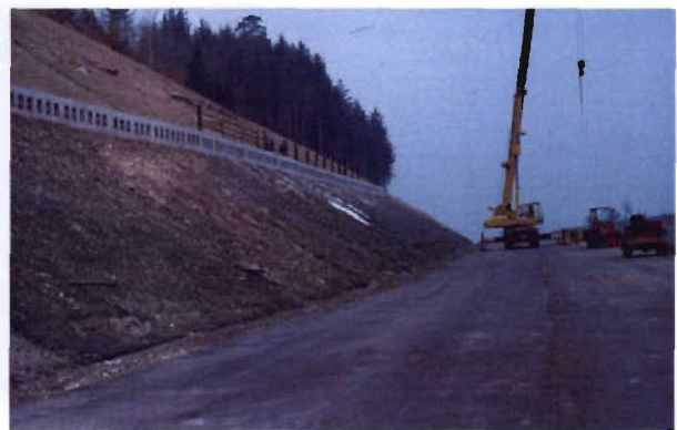
Bild 3.3-4 Verankerter Pfahlkopfbalken
