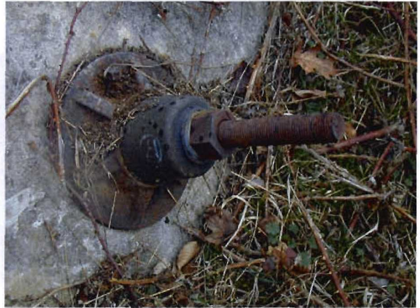
Bild 3.4-4 Ankerkopf, Kappe aufgesteckt
