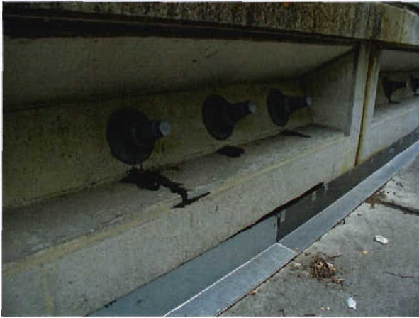
Bild 3.2-12 Austritt von Korrosionsschutzmasse Bild 3.2.-13 Austritt von Korrosionsschutzmasse
