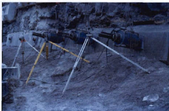
Bild 3.1-4 Zusatzverankerung während der Bauzeit Bild 3.1-5 Spannen von Zusatzankern
