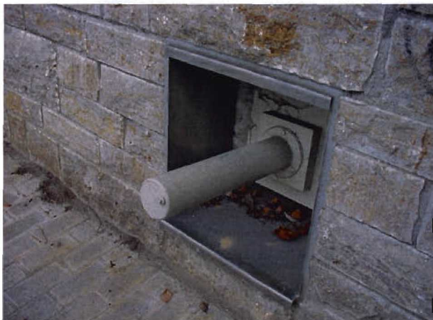
Bild 3.12-3 Ankerkopf in Edelstahlnische
