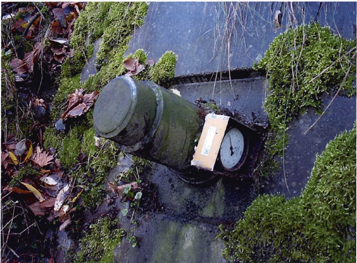
Kopf eines Dauerankers aus der Frühzeit der Ankertechnik
