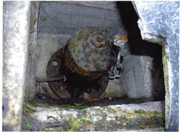
Bild 3.9-10 Angerosteter Ankerkopf
