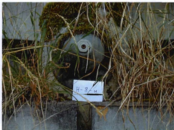
Bild 3.1-11 bewachsener Lisenenanker
