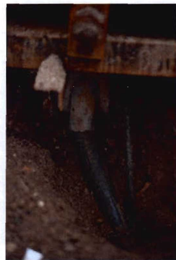
Bild 4-17 Schräg zur Spundwand gebohrter Anker
