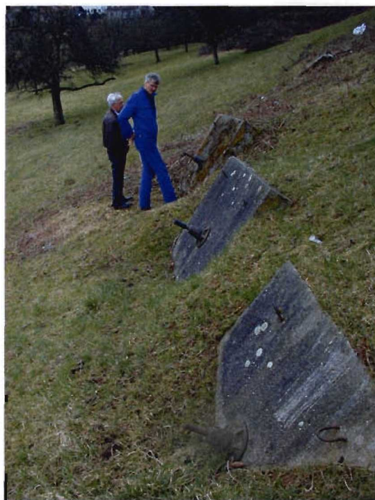
Bild 3.4-2 Verankerte Stahlbetonplatten
