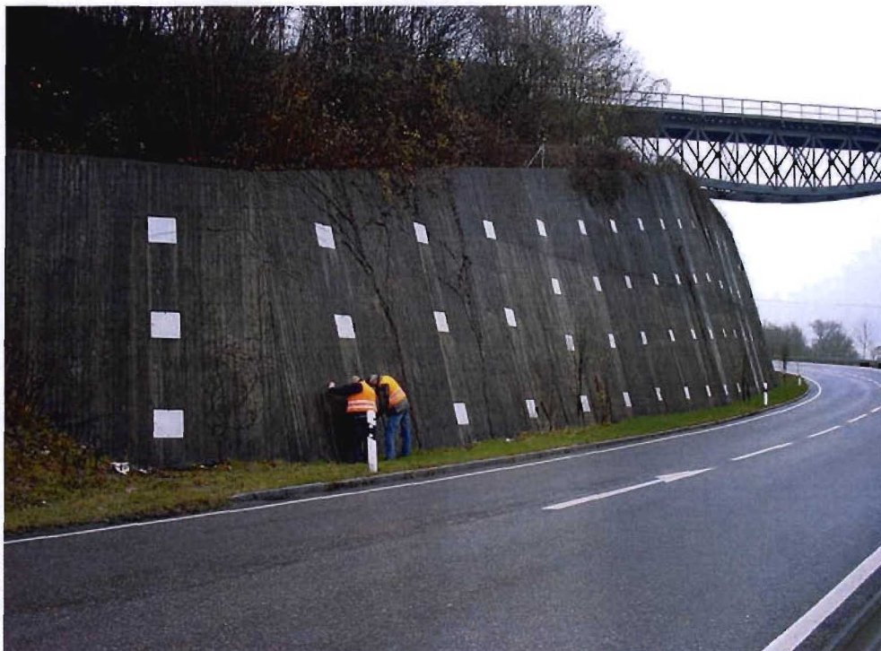
Bild 3.8-4 Verankerte Stützmauer (2002)
