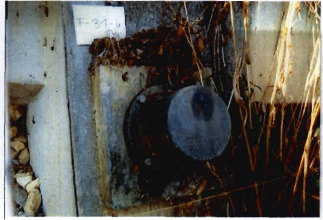
Bild 3.1-14 Verzinkter Lisenenankerkopf (Litzenanker)
