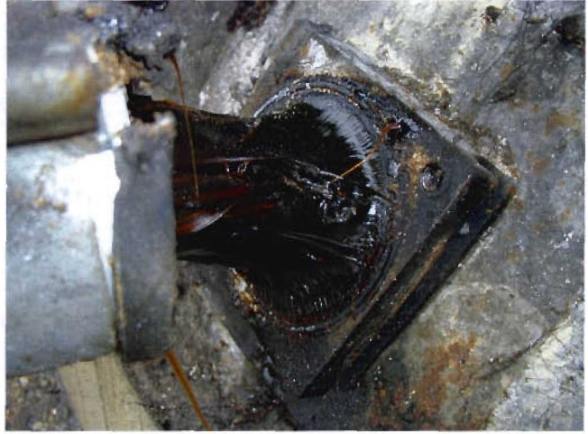
Bild 3.6-18 Zusatzanker nach Abnahme der Ankerkappe
