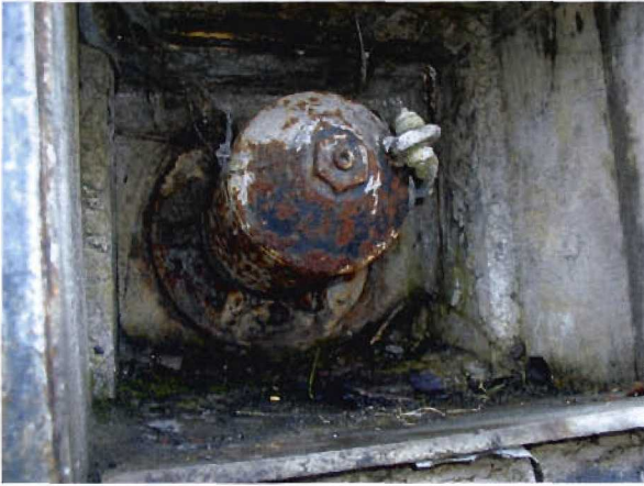
Bild 3.9-13 Ankerkopf (2002)
