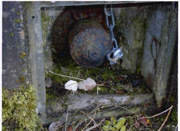
Bild 3.9-12 Ankerkopf (2002)
