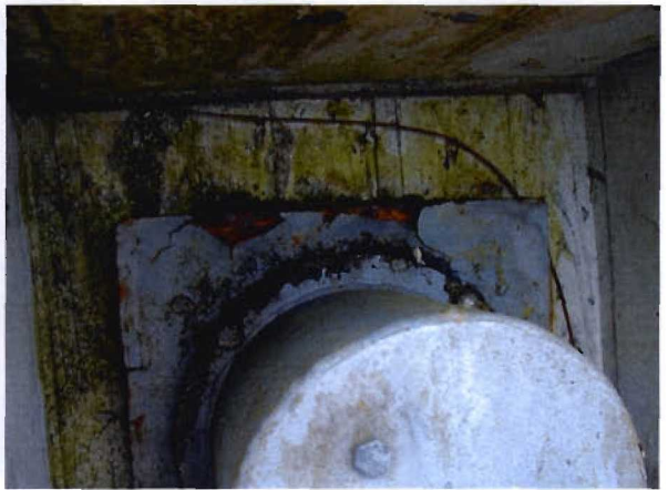
Bild 3.3-14 Rostende Auflagerplatte
