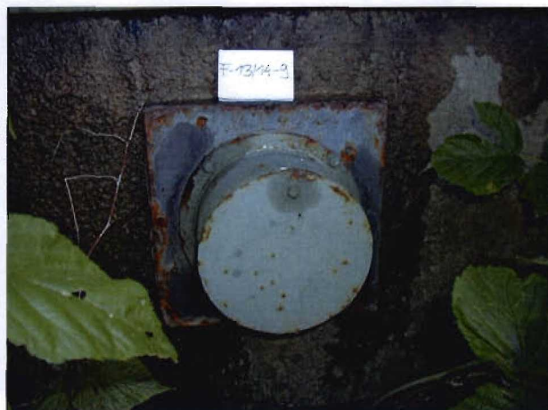
Bild 3.1-24 Rostangriff am Ankerkopf
