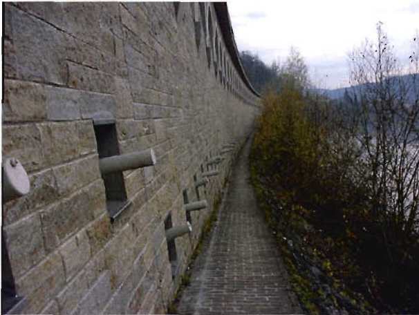
Bild 3.12-1 Stützmauer Haßmersheim, Blick nach Süden
