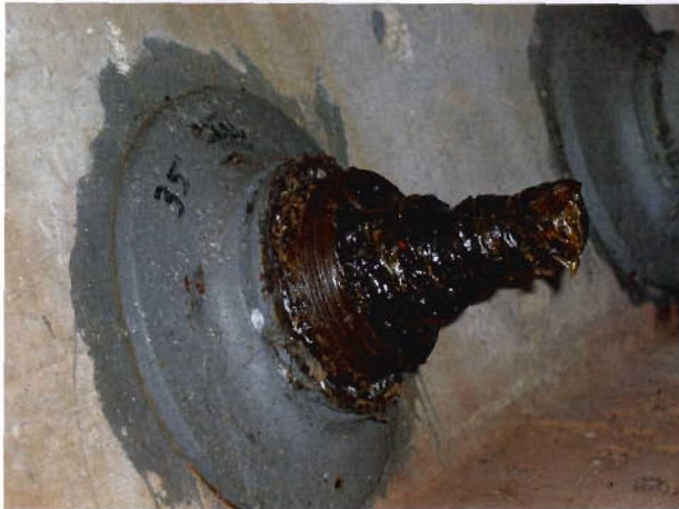
Bild 3.5-8 Ankerkopf mit abgenommener Kappe
