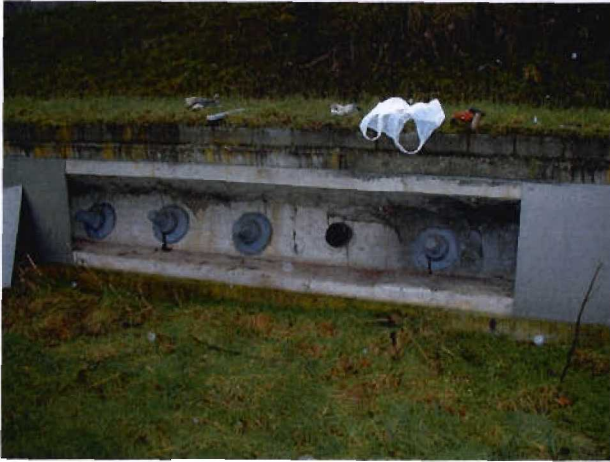
Bild 3.5-6 Teilstück des Kopfbalkens mit entfernter Abdeckung
