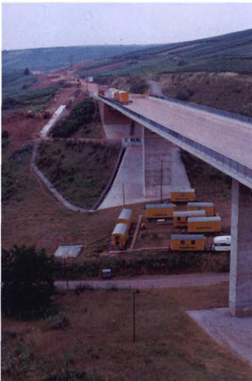
Bild 3.5-1 Talbrücke Klemmenbach mit östlichem Widerlager
