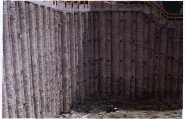
Bild 4-10 Verankerte Bohrpfehlwand
