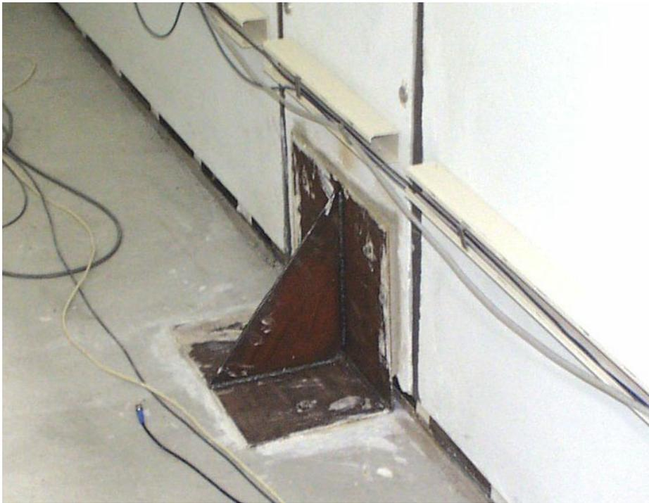
Abbildung 91 Winkel zur Fixierung des Prüfwandrahmens
