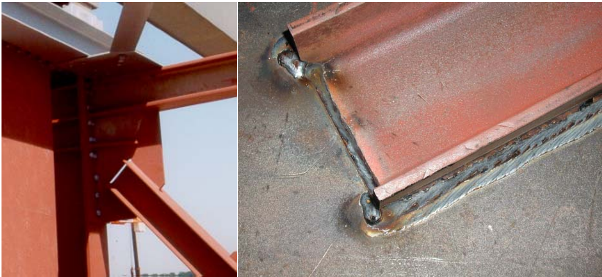
Bild 3 Links: Schlitz am Ende des eingesteckten Stabes zum Ausgleich von Montagetoleranzen Rechts: Zugeschweißter Schlitz am Stabende
