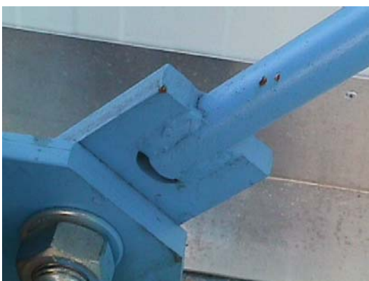
Bild 2 Links: Anschluss eines Rundstabes d = 30 mm an ein Knotenblech t = 15 mm Rechts: Makroschliff der Verbindung
