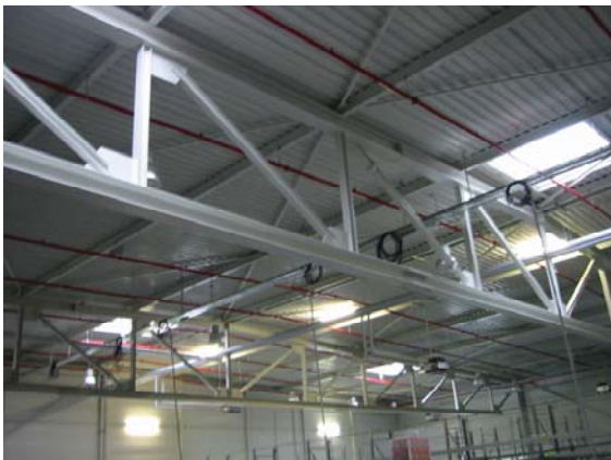
Bild 1 Links: Fachwerkkonstruktion mit HE100B – Profilen, die Diagonalen sind in Knotenbleche eingesteckt. Rechts: Makroschliff einer solchen Verbindung
