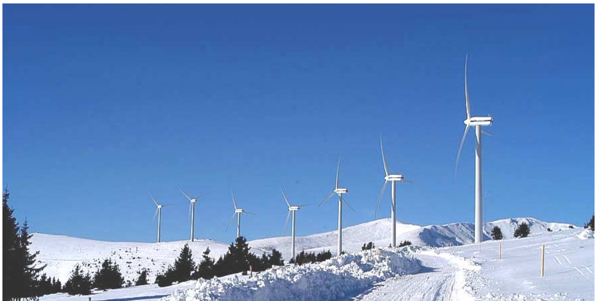
Abbildung 1 Einreihige enge Windparkaufstellung quer zur Hauptwindrichtung
