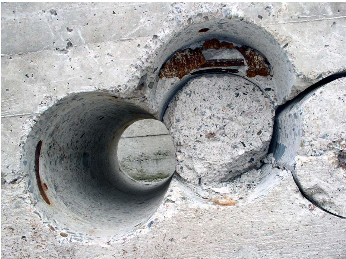
Abb. 8: Träger 2a, Kernbohrung mit angeschnittenem Spannglied 12
