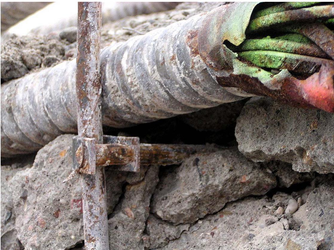
Abb. 21: SG3, Befestigung der Spannglieder
