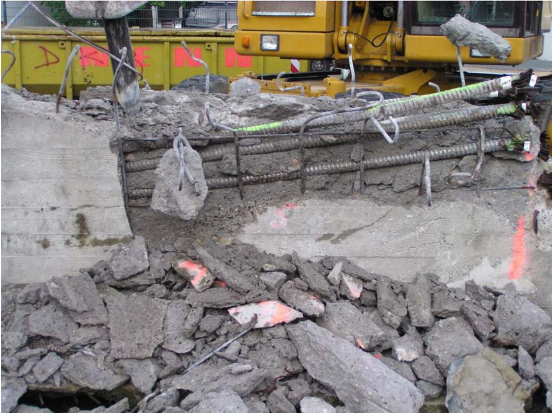
Abb. 20: Abriss Träger I Ost, von oben: SG1, SG2, SG3, Lage der senkrechten Bewehrung
