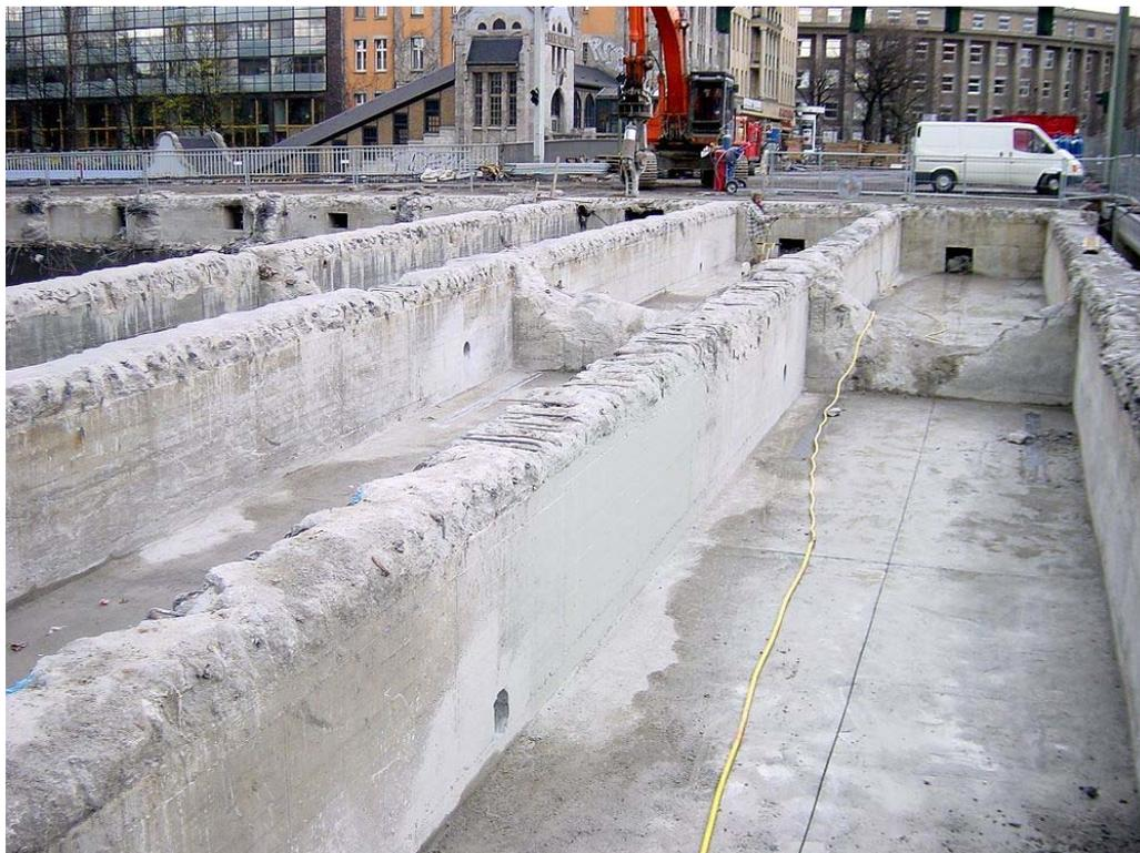
Abb. 2: Ansicht der Längsträger beim Abriss nach Entfernung der Fahrbahnplatte
