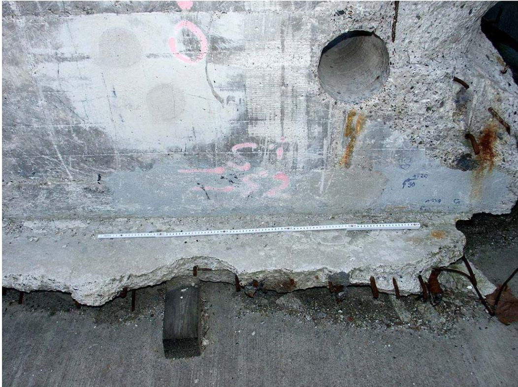
Abb. 7: Träger 2a, ehemalg Entnahmestelle von Spannstahlproben
